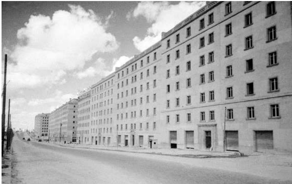
Construcción de viviendas en la Prolongación de General Mola, hoy Príncipe de Vergara, junto a la Plaza de la República Dominicana. La zona se conocía como "Las cuarenta fanegas". 1951.
