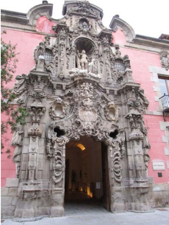
El Hospicio destaca por su fachada barroca, ejemplo del estilo churrigueresco.
