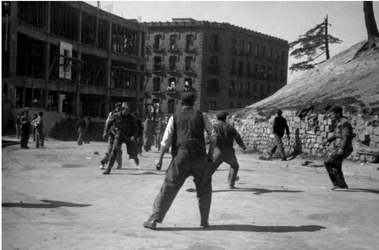
Un grupo de albañiles juega al fútbol en la calle de Irún en 1952. El edificio en construcción fue la sede de la compañía Kodak y ha sido recientemente derribado. A la derecha se ve el talud de una desolada montaña del Príncipe Pío.
