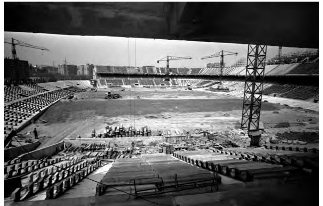
Construcción del graderío del Estadio del Manzanares, en marzo de 1966. El campo se inauguró el 2 de octubre del mismo año.
