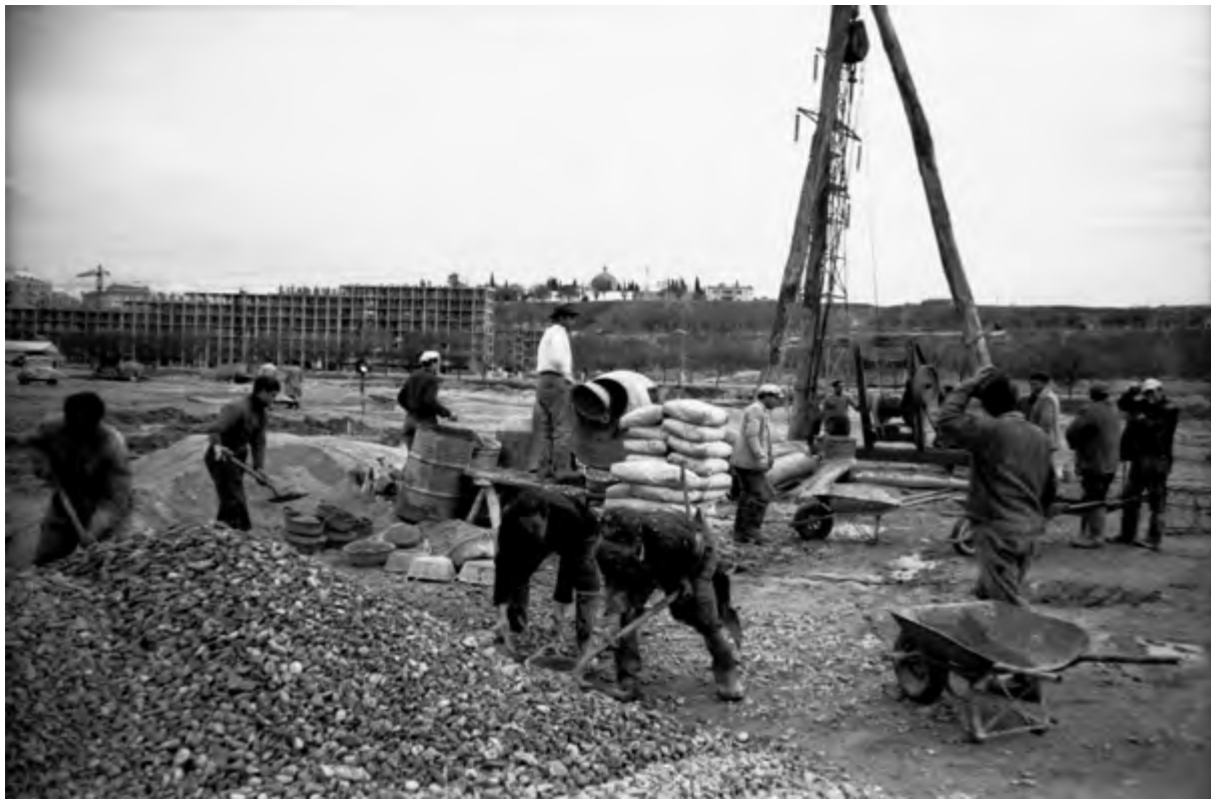
Inicio de las obras de construcción del Estadio del Manzanares en 1959, sobre el antiguo barrio de las Cambroneras. Tras él, y cruzando el río, también se construyen las viviendas del paseo del Manzanares. Al fondo, la Sacramental de Santa María, actualmente colindante con el parque de San Isidro.
