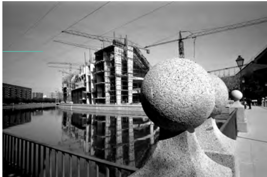
Construcción del Estadio del Manzanares.
