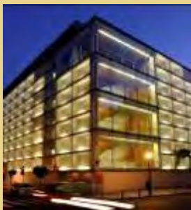
Edificio de depósitos
