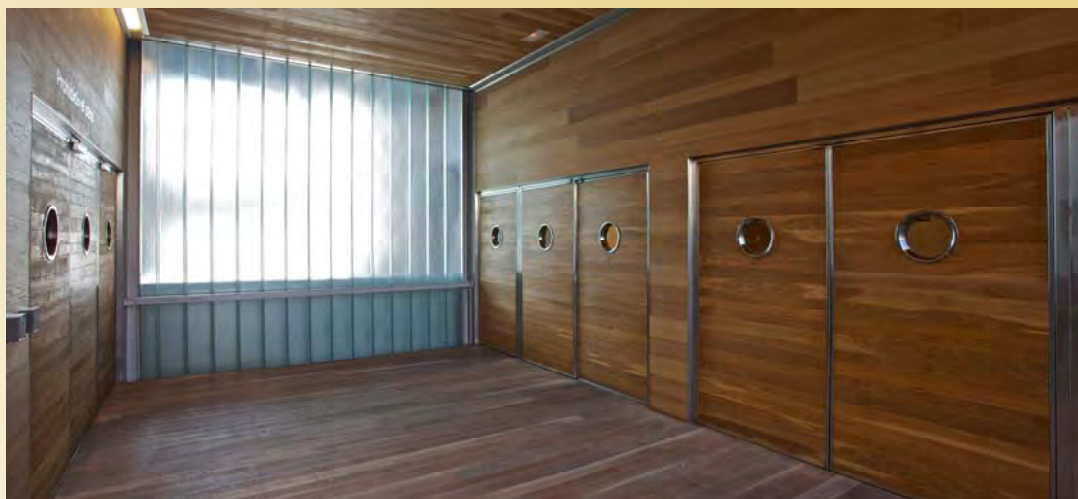
Pasarela que une el edificio de Oficinas y Atención al Público con el edificio de Depósitos.
