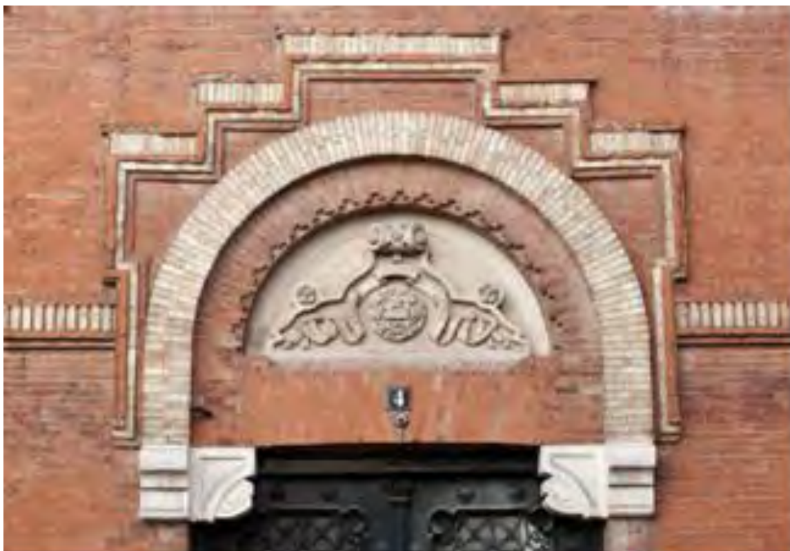
Fachada del edificio que da cabida al Archivo Histórico de Protocolos de Madrid (c/ Alberto Bosch 4, 2º planta).
