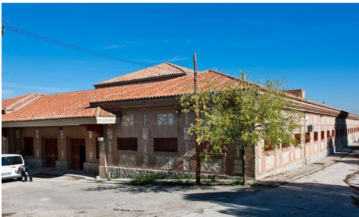
Edificio Matadero del Complejo 'Colegio de San Fernando'.
