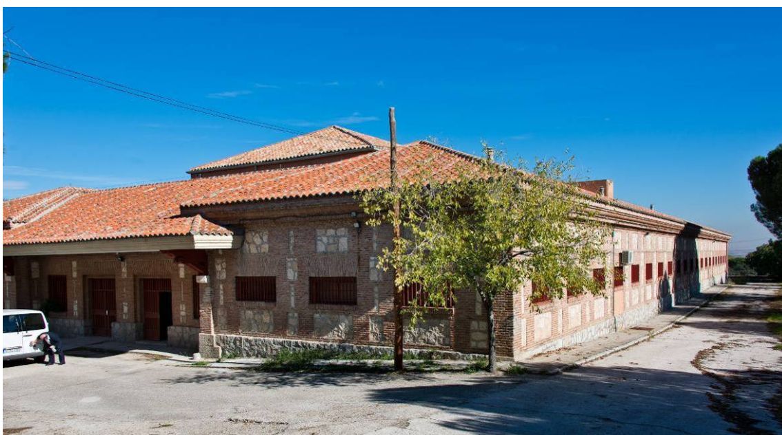
Edificio Matadero del Complejo Ciudad Escolar-San Fernando.
