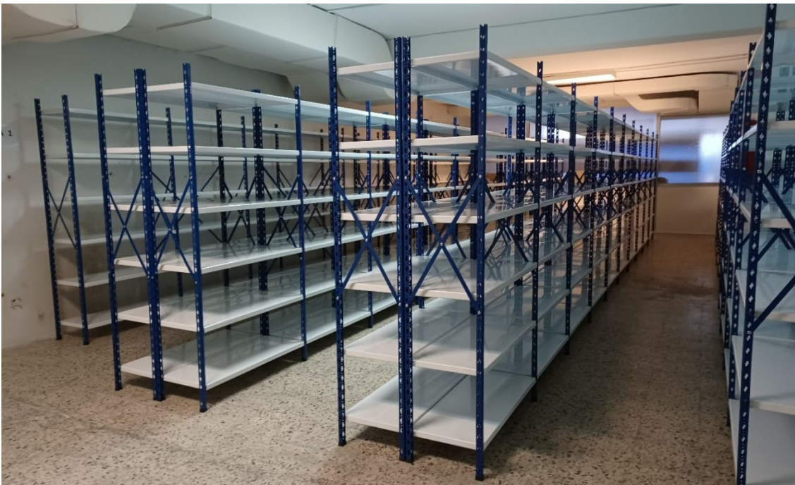
Uno de los depósitos de archivo central del SDAC de la Consejería de Sanidad, en el Edificio Europa del Polígono Industrial de Vallecas.
