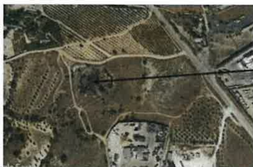
Balsa de hidrocarburos
