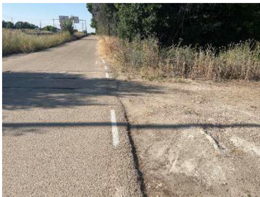
Imagen 36. Terrenos para la implantación de la línea subterránea de evacuación PSF Belvis
