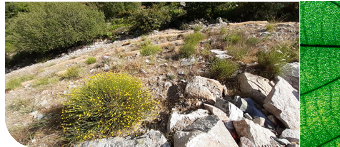
Cantera del Jaralón: detalle biorrollos de control de erosión
