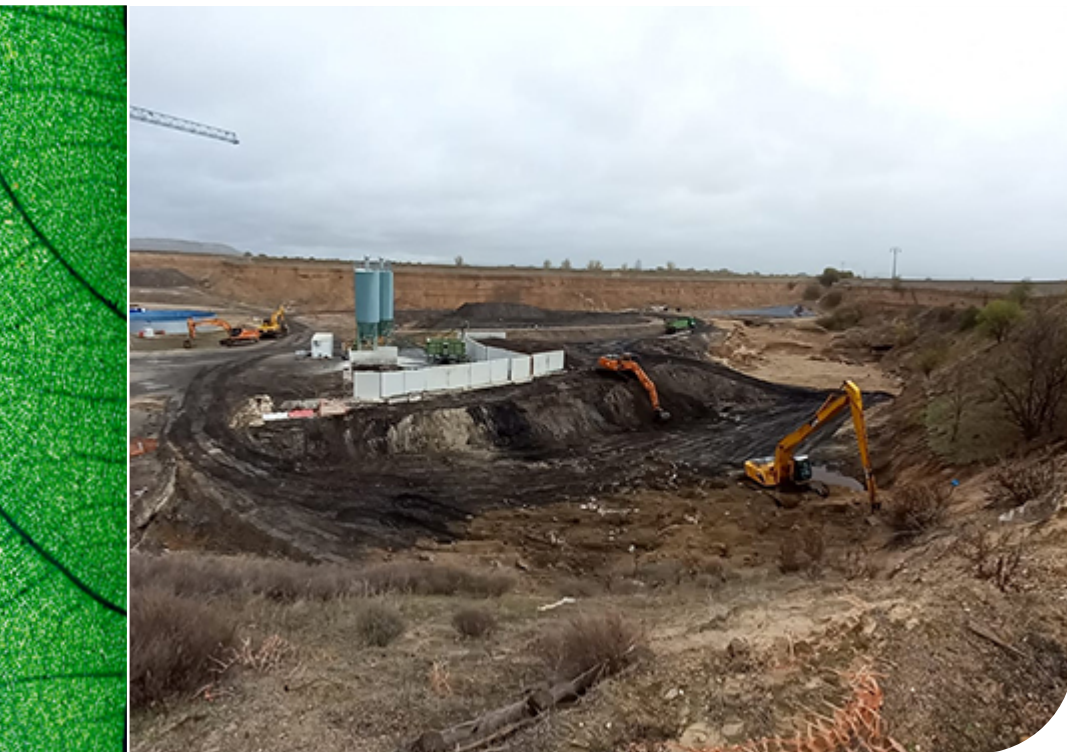
Vista de la laguna sureste durante los trabajos de extracción de los residuos por medios mecánicos.
