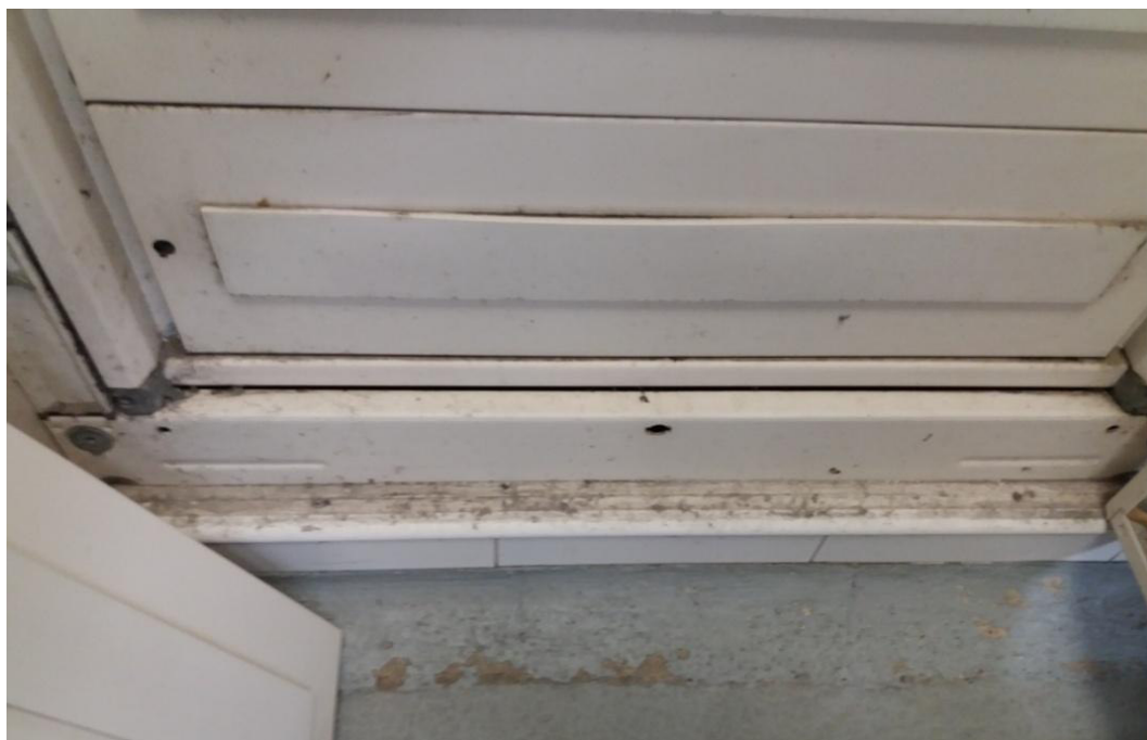
Ilustración 33: Cuadro eléctrico general de la cocina (parte inferior)
