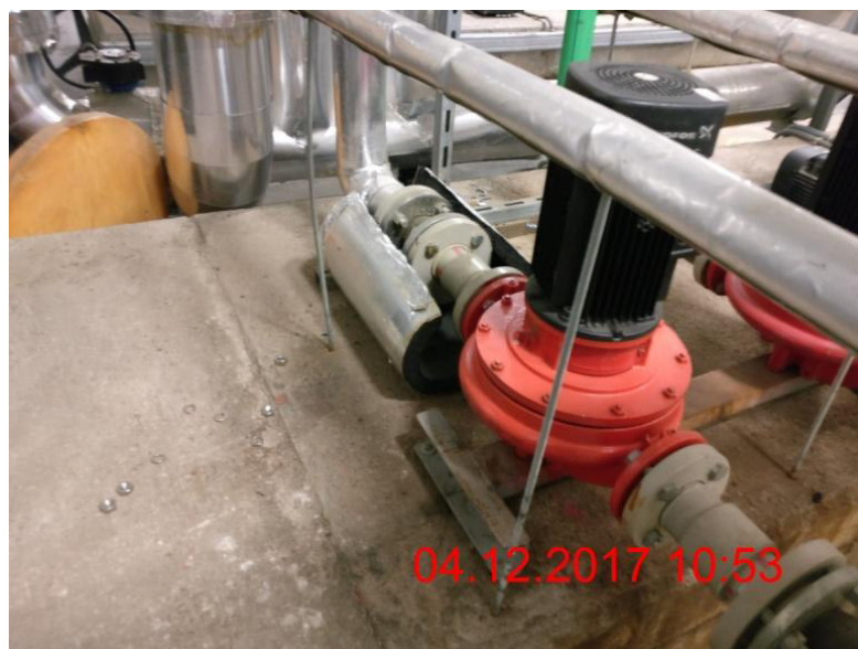
Ilustración 141: Red de distribución de ACS
