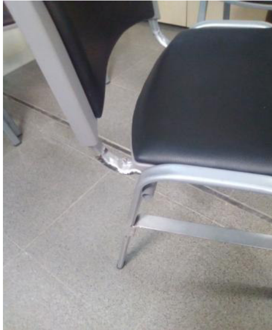
Silla fija deteriorada
