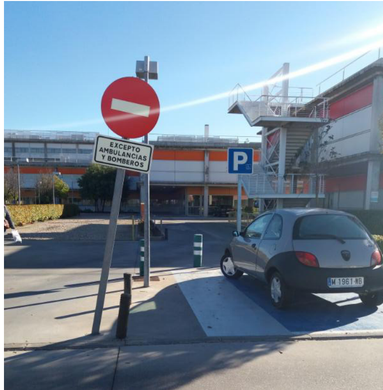
Ilustración 148: Señal de tráfico torcida en el aparcamiento
