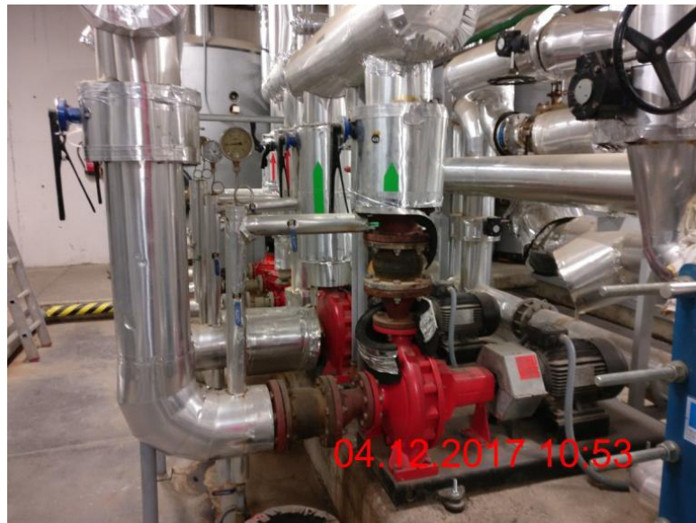
Ilustración 140: Red de distribución de ACS
