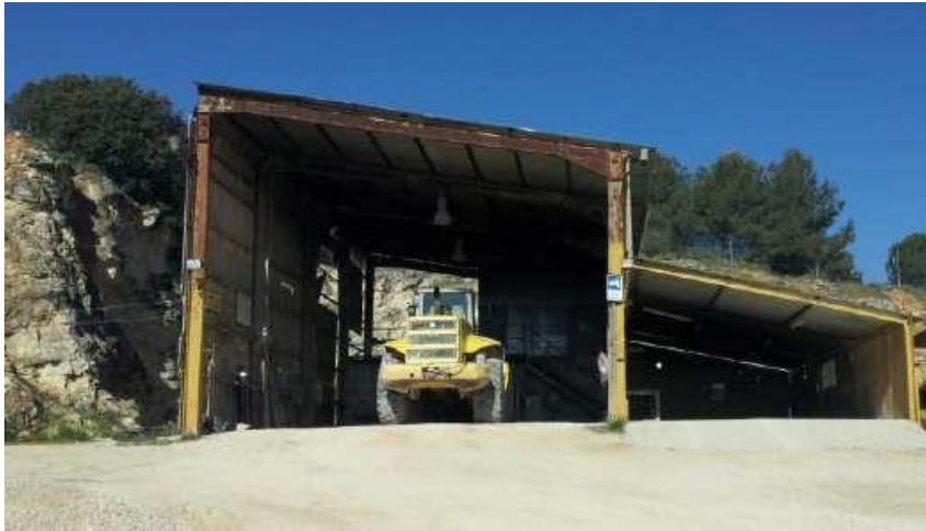
Figura 26. Detalle de la nave taller.
