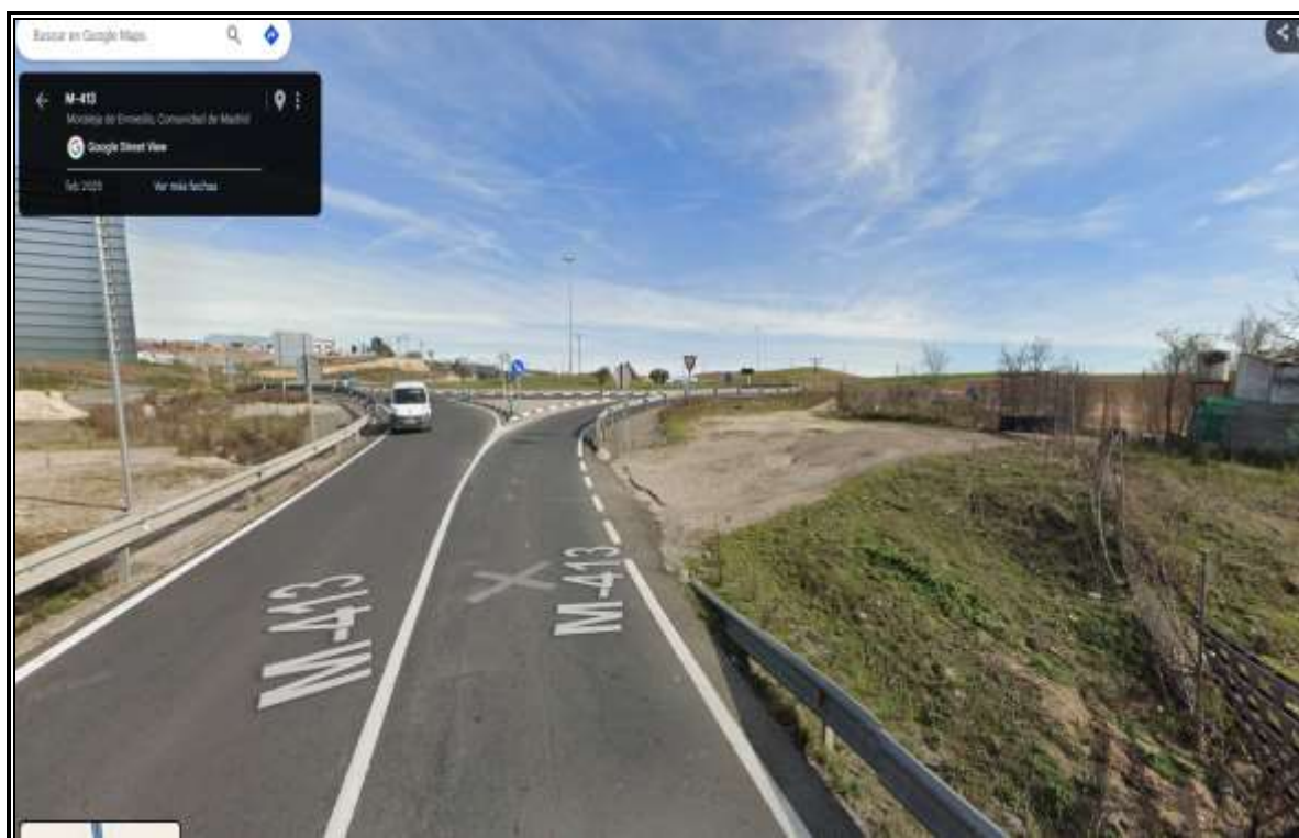
ACCESO EXISTENTE M-413, PK 7+550, MARGEN IZQUIERDO.
