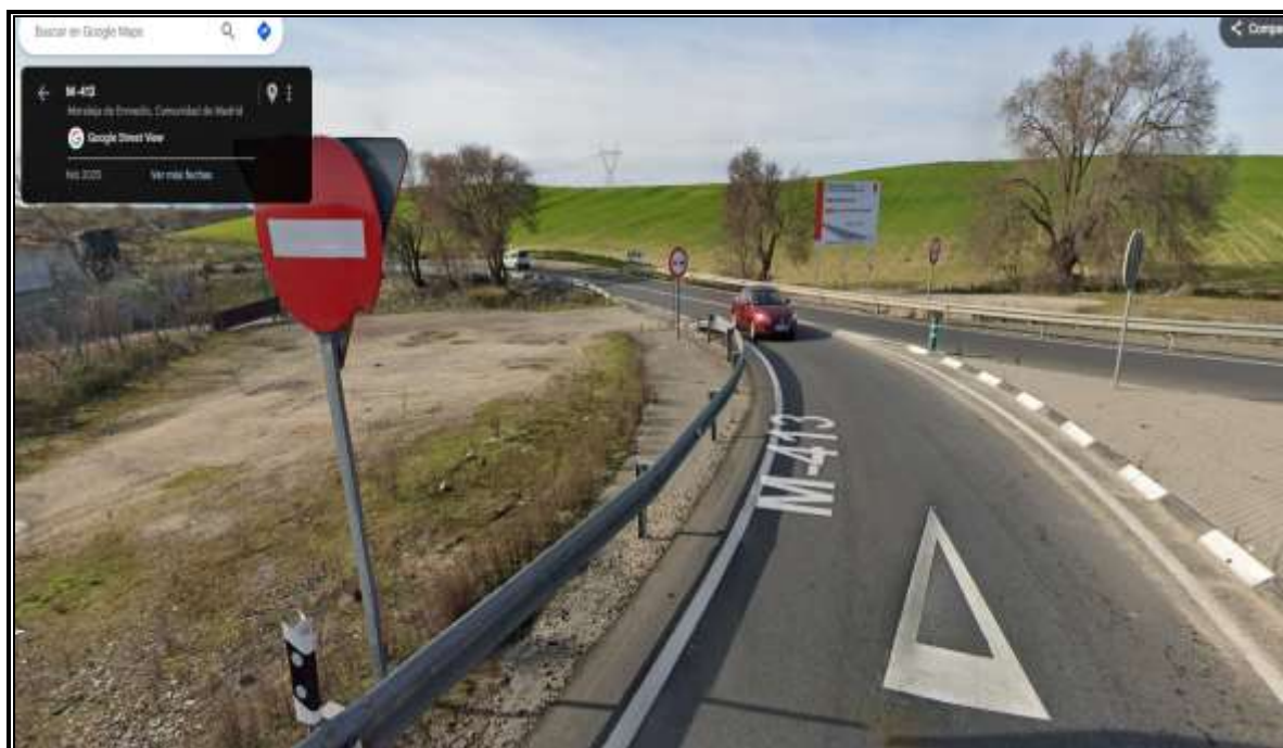
ACCESO EXISTENTE M-413, PK 7+550, MARGEN IZQUIERDO.
