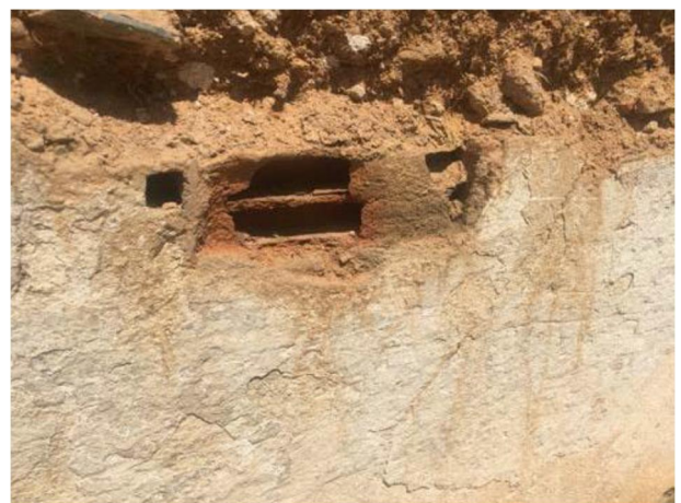
Detalles muro tapial
