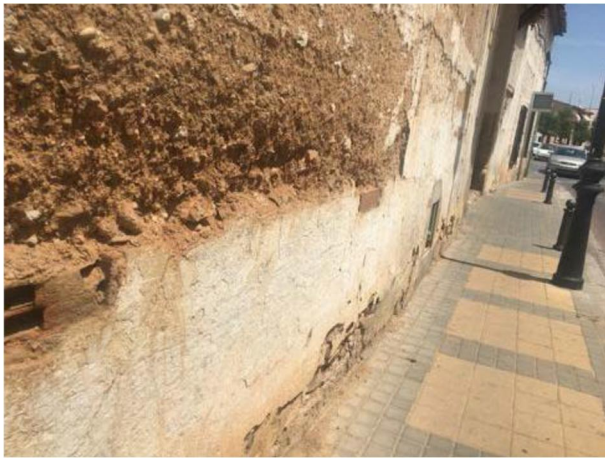
Detalle muro fachada calle Mayor
