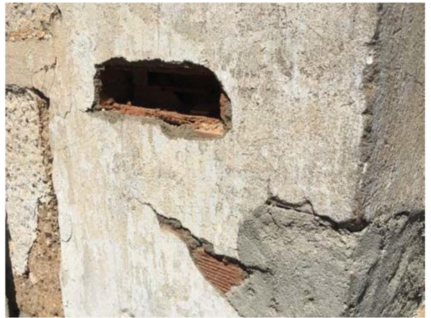
Detalles muro tapial
