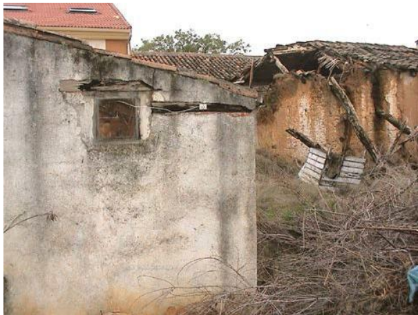
Construcciones interiores de la parcela
