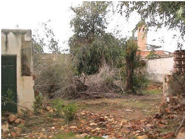
Construcciones interiores de la parcela
