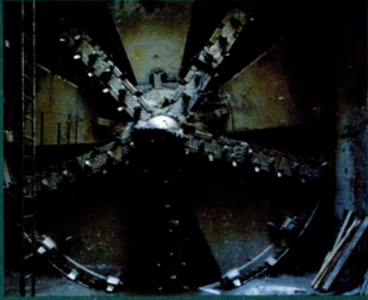
Tuneladora - Vista frontal
