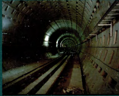
Tuneladora - Aspecto final
