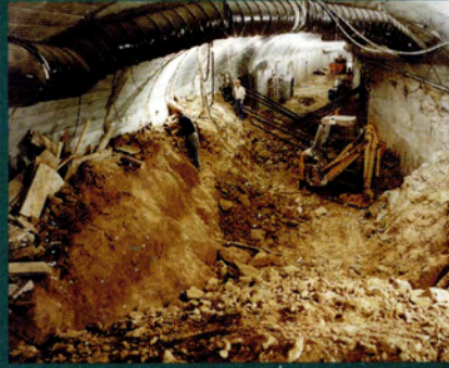
M. Tradicional - Aspecto hormigonado hastial derecho
