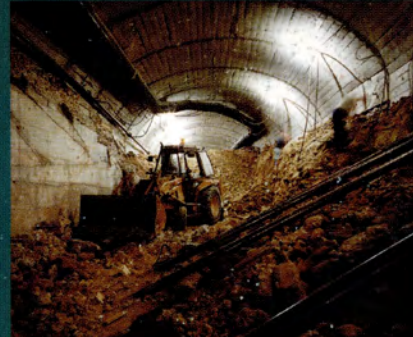
M. Tradicional - Aspecto hormigonado hastial izqdo y vaciado
