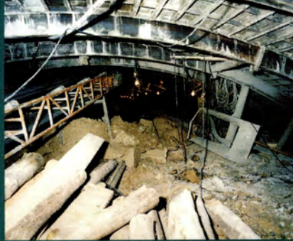
M. Tradicional - Encofrado para hormigonado de bóveda
