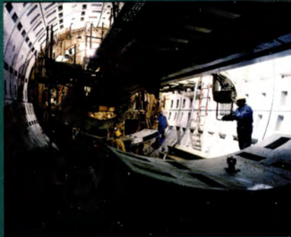
Tuneladora - Entrada de dovelas
