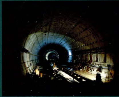
Tuneladora - Aspecto del túnel
