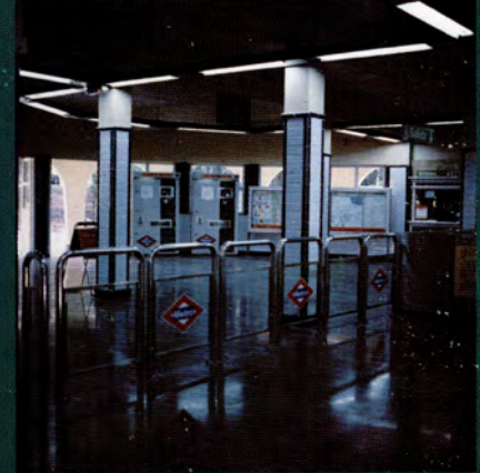
Lago - Aspecto del vestíbulo
