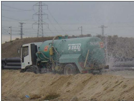
Foto 10.1. Riego para control de la contaminación atmosférica
