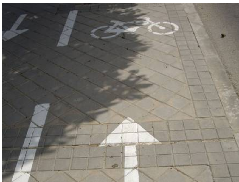
Acera-bici con pavimento de baldosa hidráulica.
