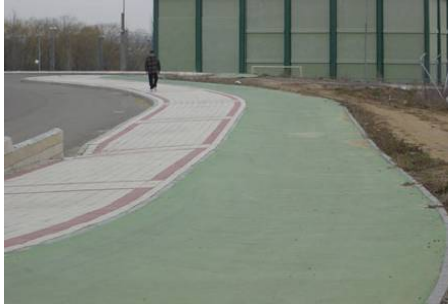
Aspecto de carril bici con pavimento de slurry
