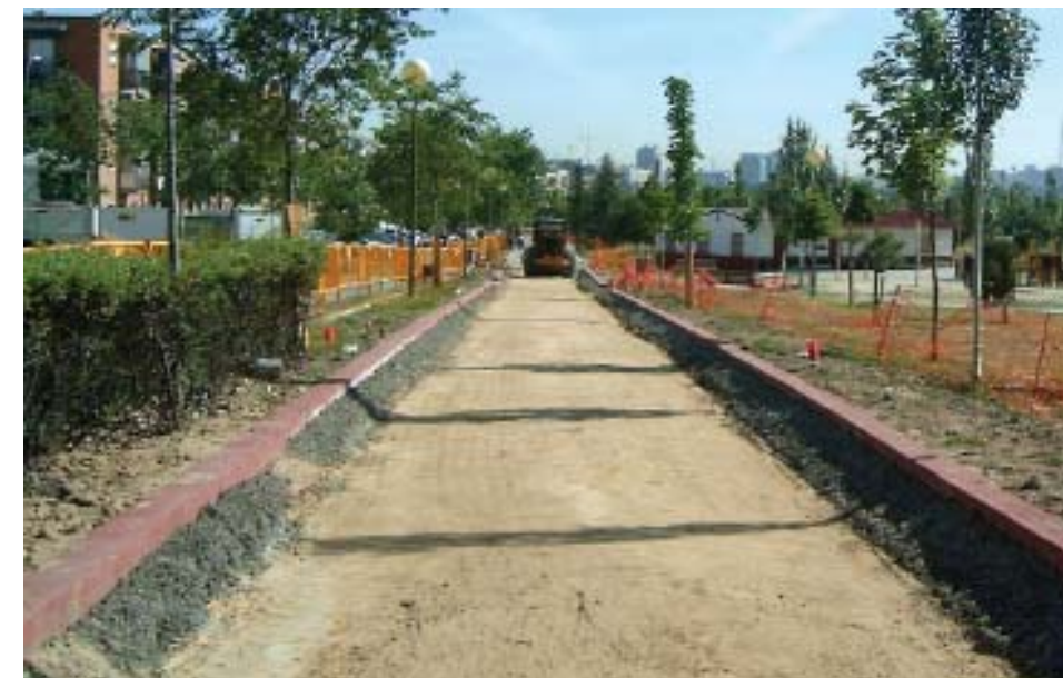
Ejecución de capa de base con encintado previo.
