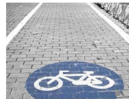
Carril-bici sobre adoquinado
