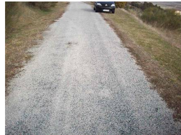
Aspecto de un pavimento con doble tratamiento superficial
