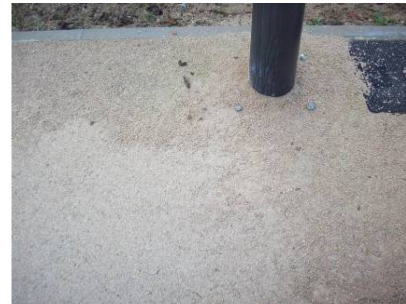
Pavimento terrizo estabilizado, con capa de gravilla superficial.
