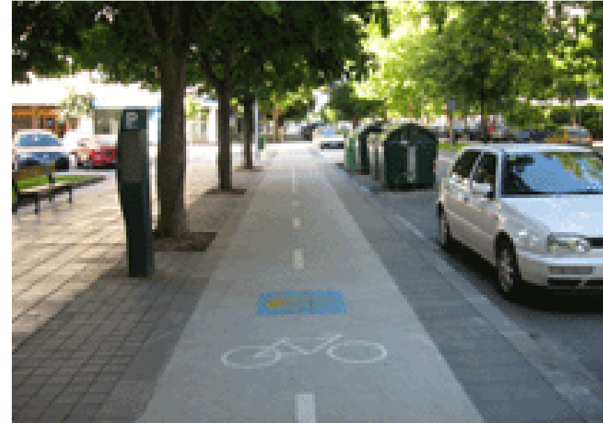
Acera-bici con pavimento de hormigón.
