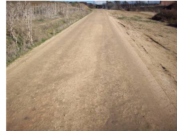
Aspecto de pavimento de zahorra compactada.
