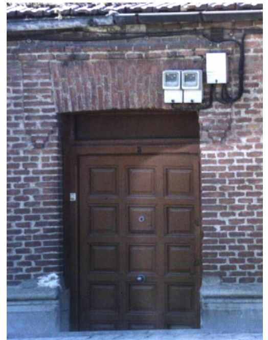
Fig. 4: Caja general de protección en fachada.
