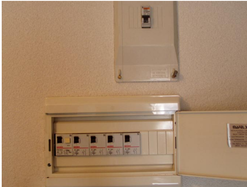
Figura: ICP, en la parte superior, con el CGD en la parte inferior. El ICP va precintado.
