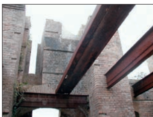
Imagen 144. Apertura de huecos en forjados
