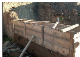
Encofrado y vertido
