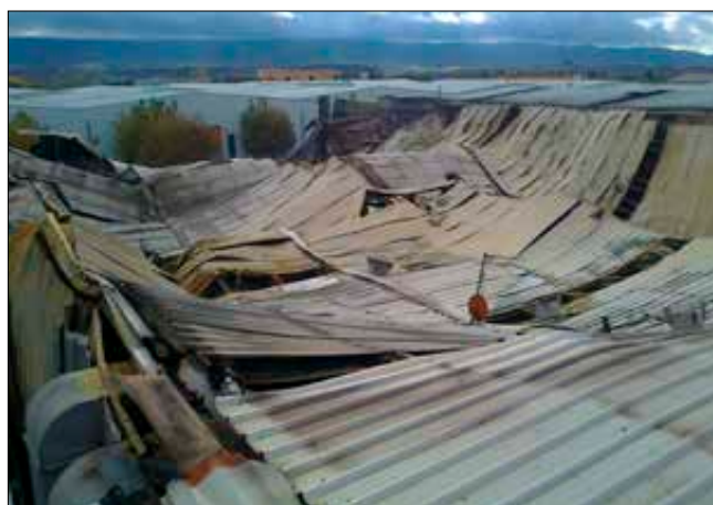
Imagen 447. Comportamiento del acero al fuego
