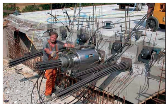
Imagen 74. Hormigón pretensado (armadura postesa)
