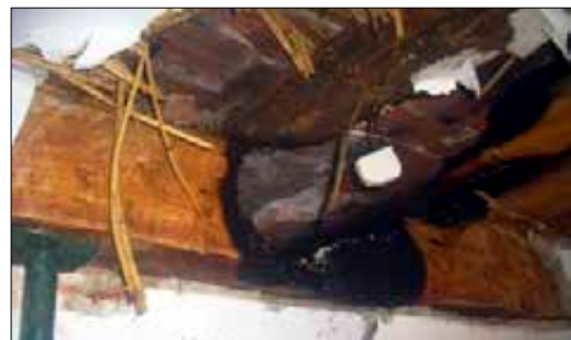
Imagen 456. Comportamiento al fuego de la madera
