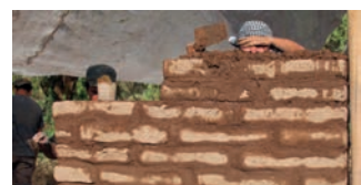
Imagen 100. Ejecución fábrica
