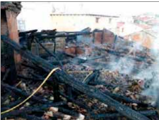
Imagen 457. Estructura de fábrica tras incendio
