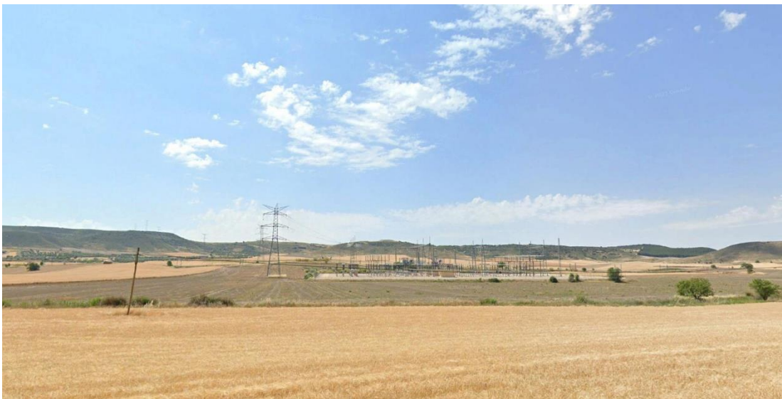
Figura 89. No obstante, esa misma unidad presenta una zona calificada como de "Baja Calidad" paisajística debido a la presencia de la Subestación de REE de Anchuelo y la proliferación de LEATs en su entorno. Es precisamente esta zona la que se determina como apta para albergar un Corredor de Infraestructuras por la Estrategia de Corredores de la Comunidad de Madrid. Fuente: Google Earth.
