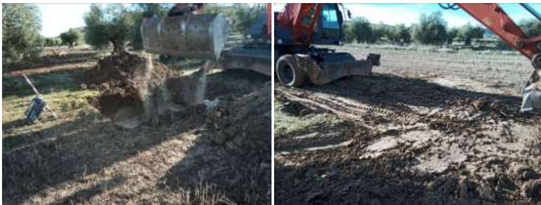
Proceso de tapado de los sondeos realizados
