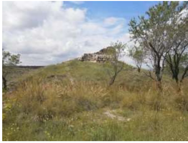
Vista general de la estructura.
