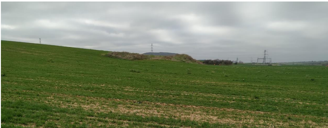
Figura 134. Vista en detalle del emplazamiento del apoyo T-56 en el que se observa como la cercanía de la subestación desvirtúa la calidad paisajística de la zona. Fuente: elaboración propia.
