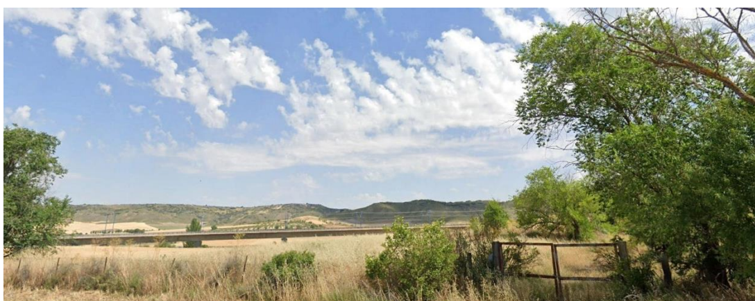
Figura 144. Vistas de la localización de los apoyos T-53 y T-54 desde las inmediaciones del núcleo urbano de Anchuelo, en el que se observa la posición intermedia de la plataforma elevada del AVE.
