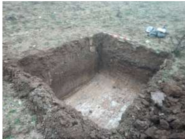
Detalles del sondeo finalizado
