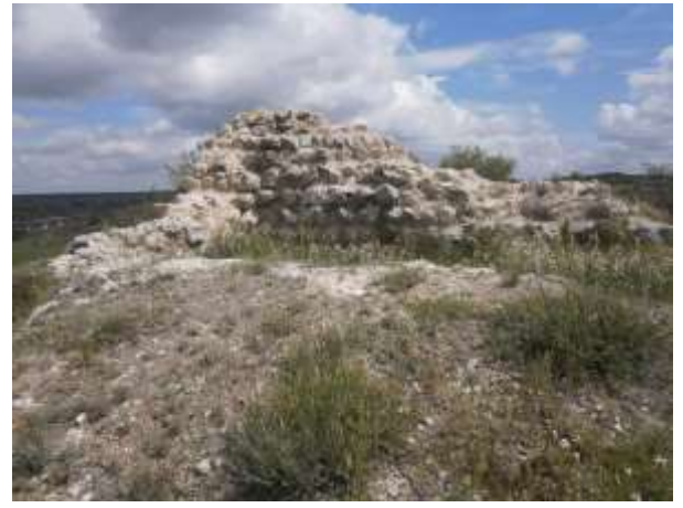
Se encuentra en avanzado estado de ruina.
