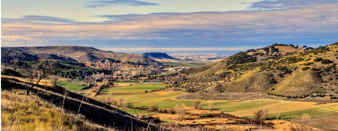
Figura 129. Vistas desde la atalaya de Santorcaz hacia el valle del arroyo de Anchuelo y el núcleo del mismo nombre. Los apoyos T-45 y T-46 se sitúan, respectivamente sobre el fondo del valle (esquina inferior derecha) y sobre la ladera del cerro situado a la derecha de la imagen. Fuente: WIKILOK.
