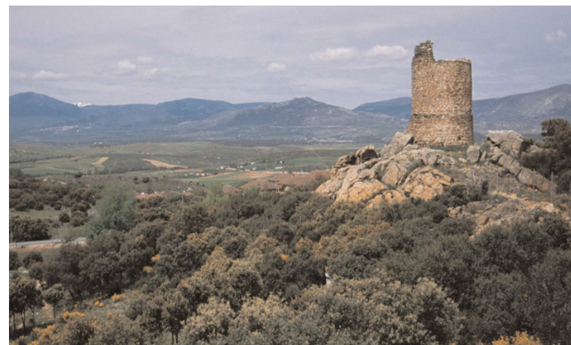
Fig. 12 Restos de la barbacana conservados en el tramo oeste del recinto
