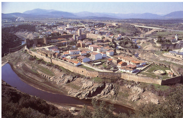
Fig. 3 Vista general del recinto fortificado de Buitrago del Lozoya
