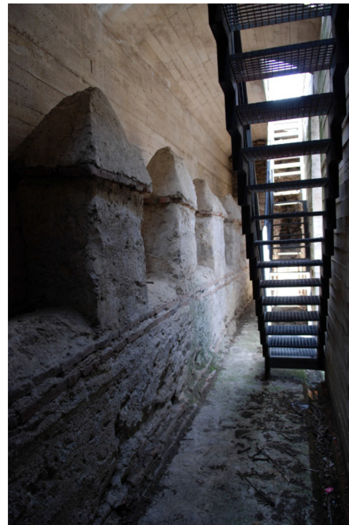
Fig. 10 Restos del adarve de la primitiva muralla
