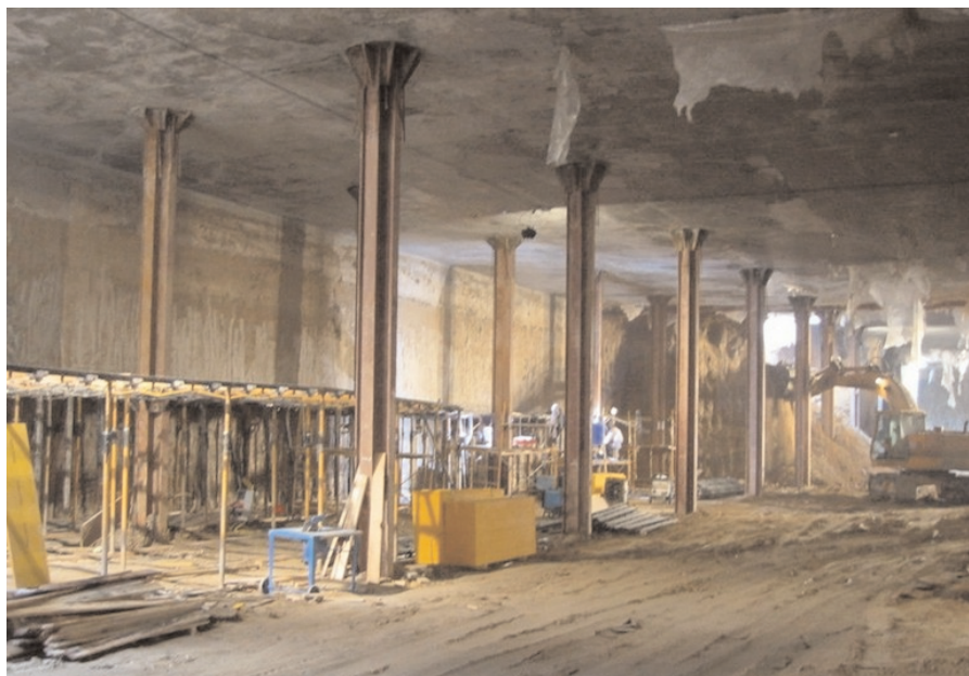
Figura 19. Construcción de sótanos. Figure 19. Basement construction.
