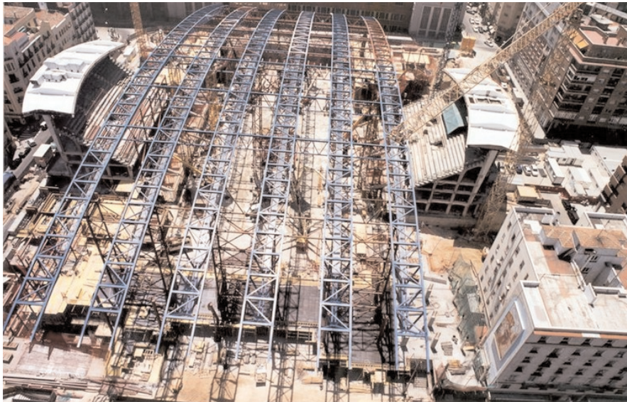
Fig. 22. Construcción de estructura de cubierta. Figure 22. Construction of roof structure.
