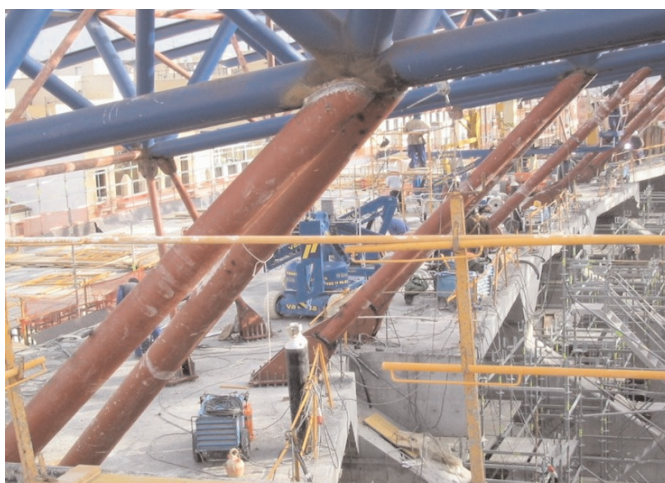
Figuras 16 y 17. Detalle de apoyo de las vigas longitudinales en el lado Goya. Figures 16 and 17. Detail of the connection between longitudinal roof beams and concrete pilaster on Goya side.
