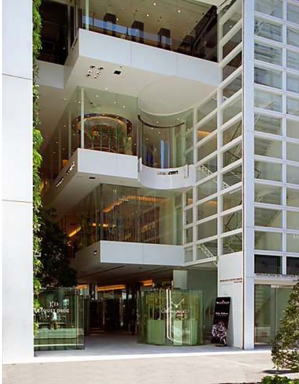
Acceso y vista interior de la Calle del Tiempo, zona de libre tránsito en la planta baja en la que se aprecian los ascensores de cristal, Nicolas Hayek Center Building, Ginza Tokio Arup, 2007
