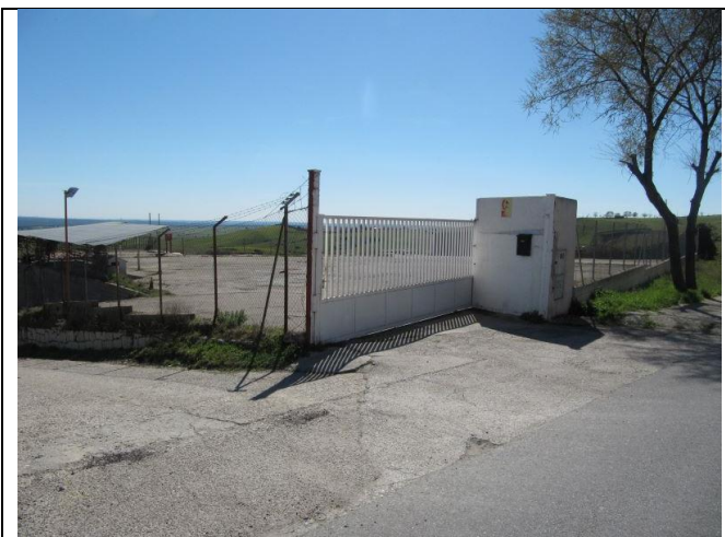
Actividad en el ámbito, al sur del polígono industrial
