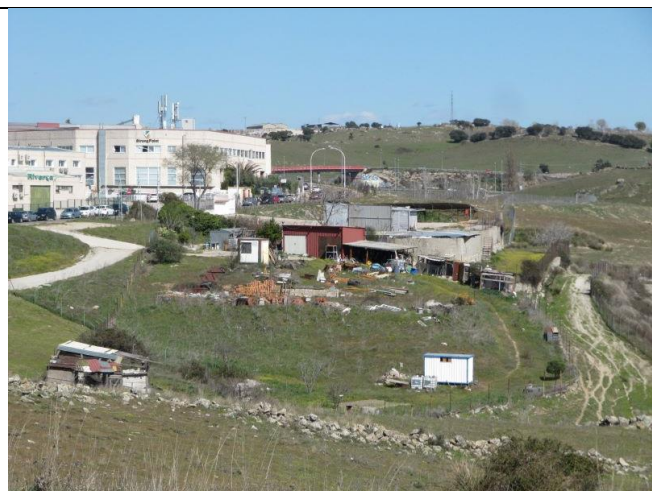
Edificaciones y vertidos al oeste de la zona anterior
