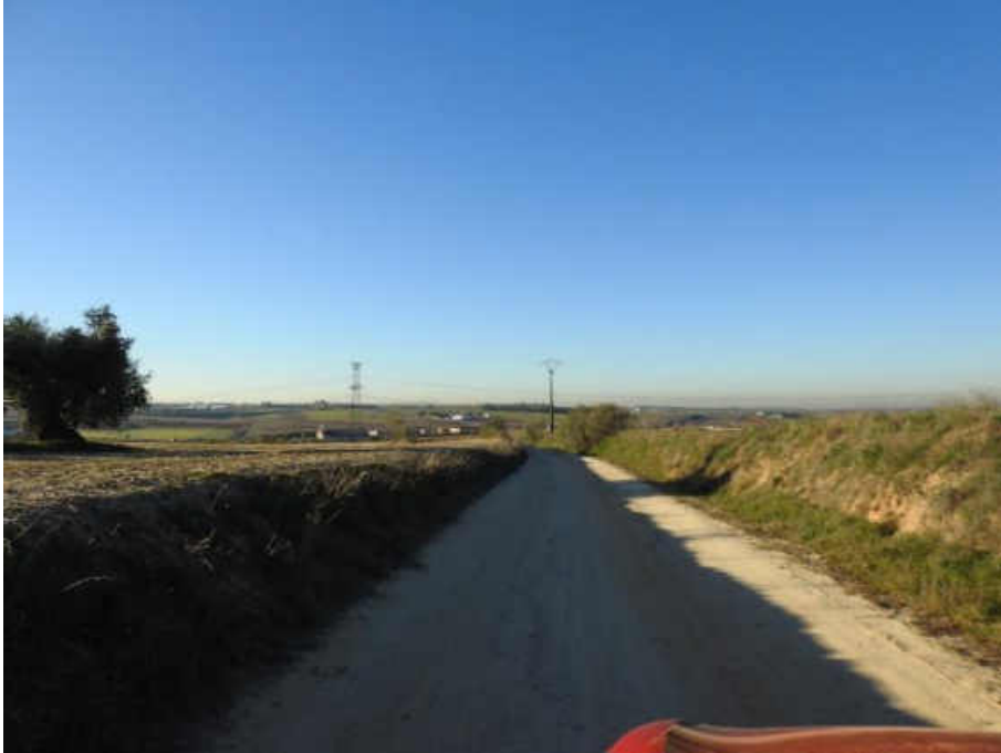
Inicio tramo subterráneo
