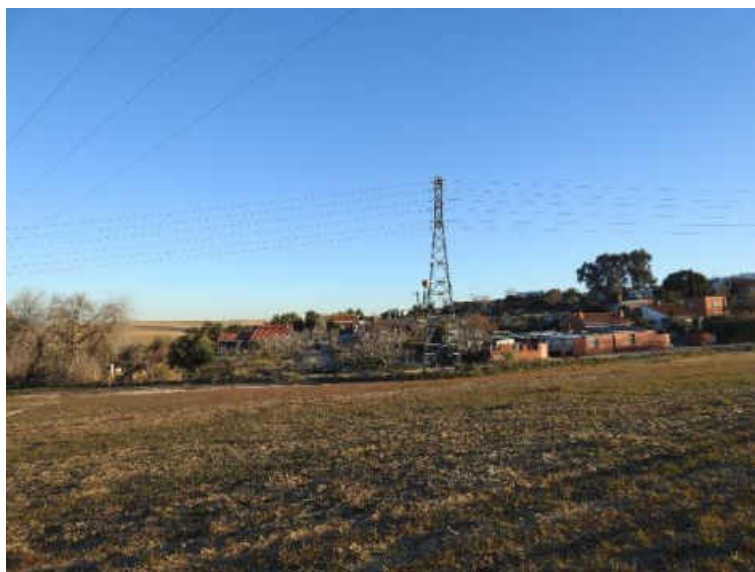
Fotografía 14. Urbanización Valdemiendas. Fuente: AmbiNor.
