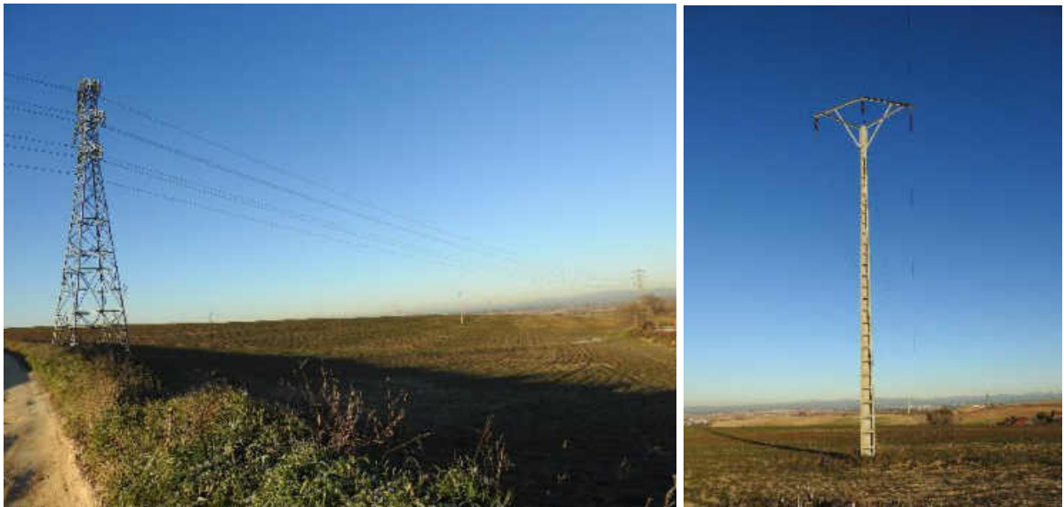
Fotografía 17. Líneas eléctricas media tensión 45 y 15 KV que cruzan por la planta solar. Fuente: AmbiNor.
