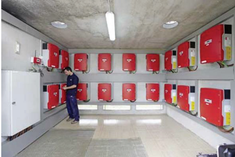
Imagen 6. Ejemplo de instalación de inversores distribuidos
