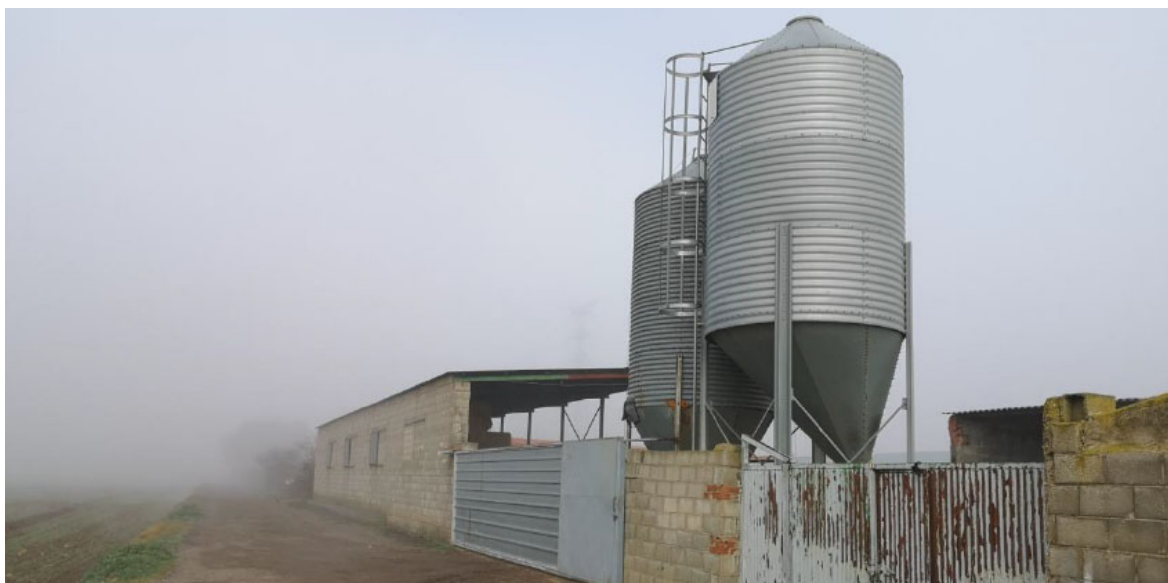
Naves agro-ganaderas existentes en la parcela 286 del polígono 023
