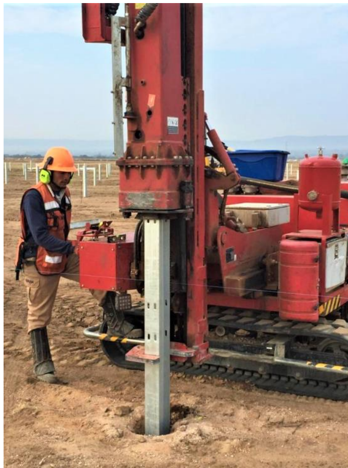
Figura 2: Máquina Hincaposte
