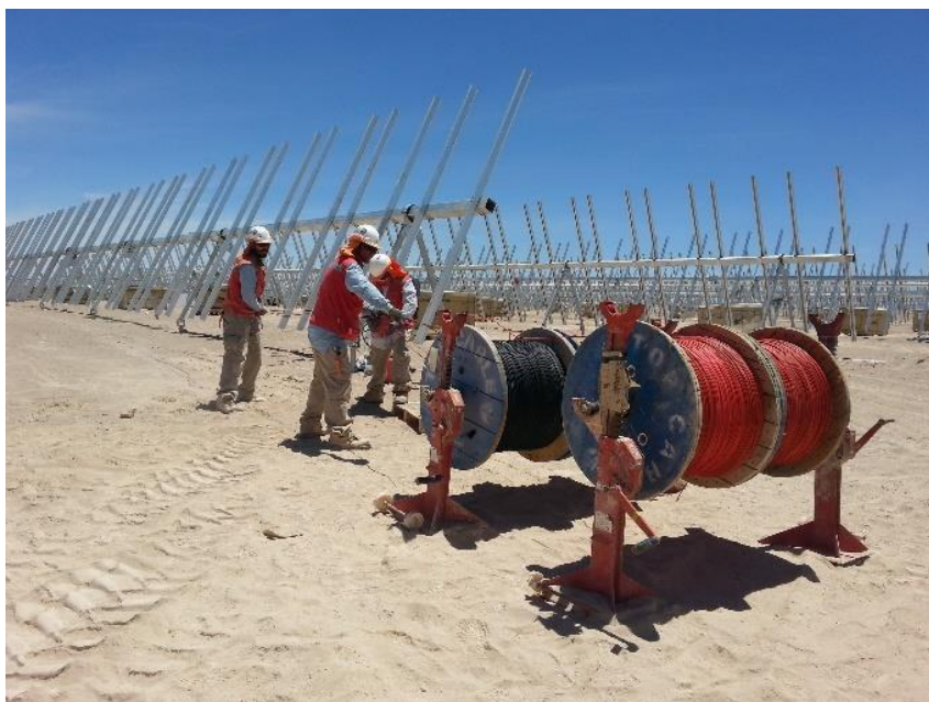
Figura 4: Tendido de cables eléctricos
