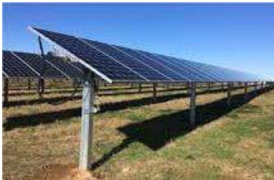
Imagen 3. Estructura giratoria a un eje
