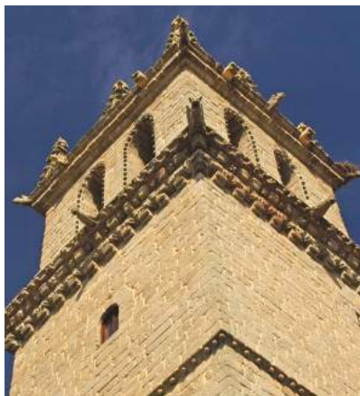
Detalle de la torre de la Iglesia
