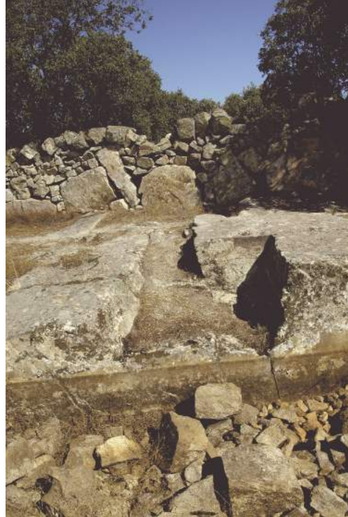
Pequeña cantera dentro de la vía pecuaria para la obtención de piedra de granito
