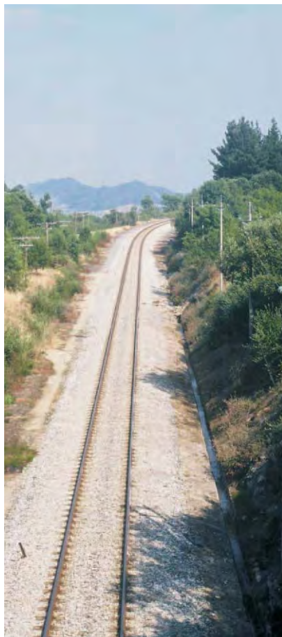
Cruce con la vía del tren Madrid-Burgos-Irún
