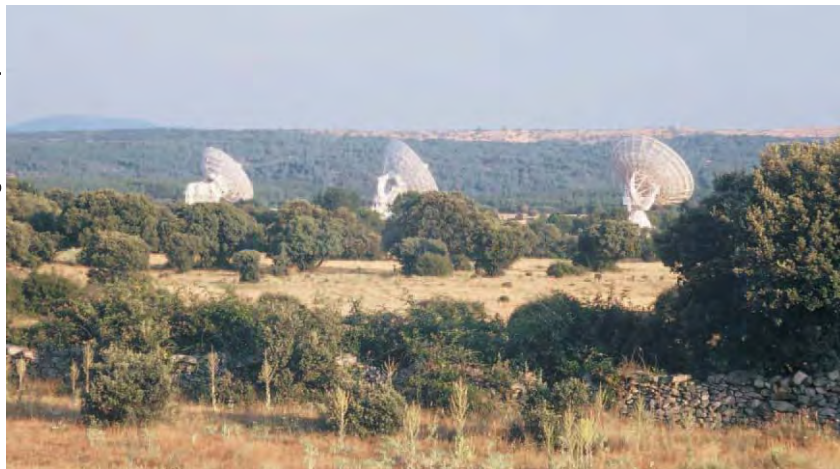
Antenas de la Estación de Seguimiento Espacial
