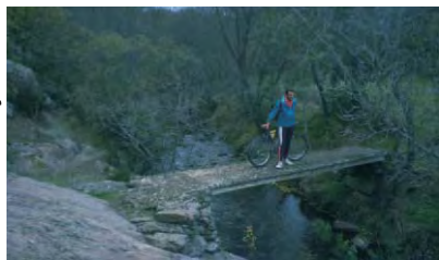
Puente sobre arroyo La Garita
