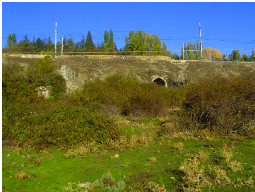
El túnel bajo la vía del tren
