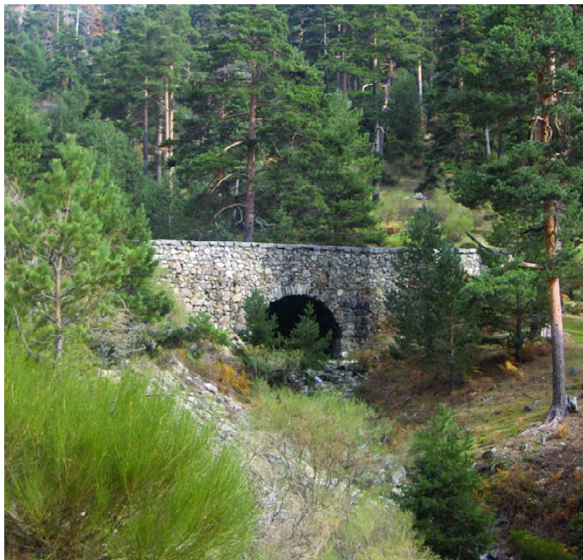
El puente de Enmedio
