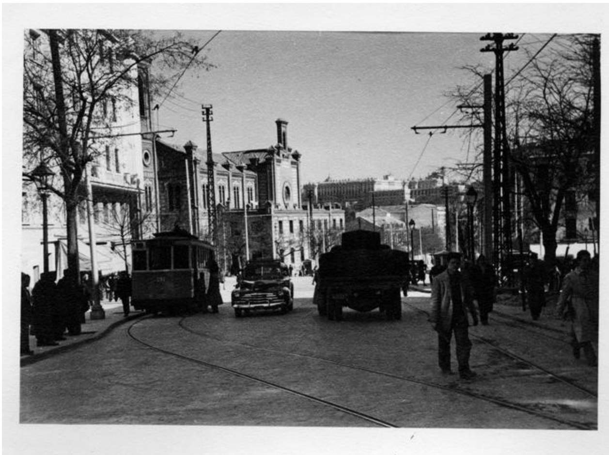
Paseo de Extremadura
