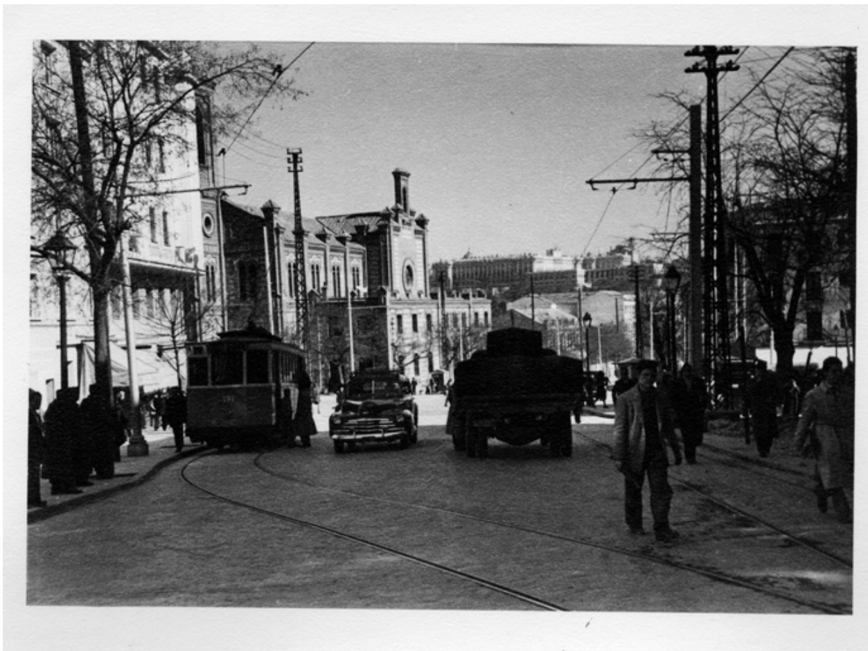
Paseo de Extremadura
