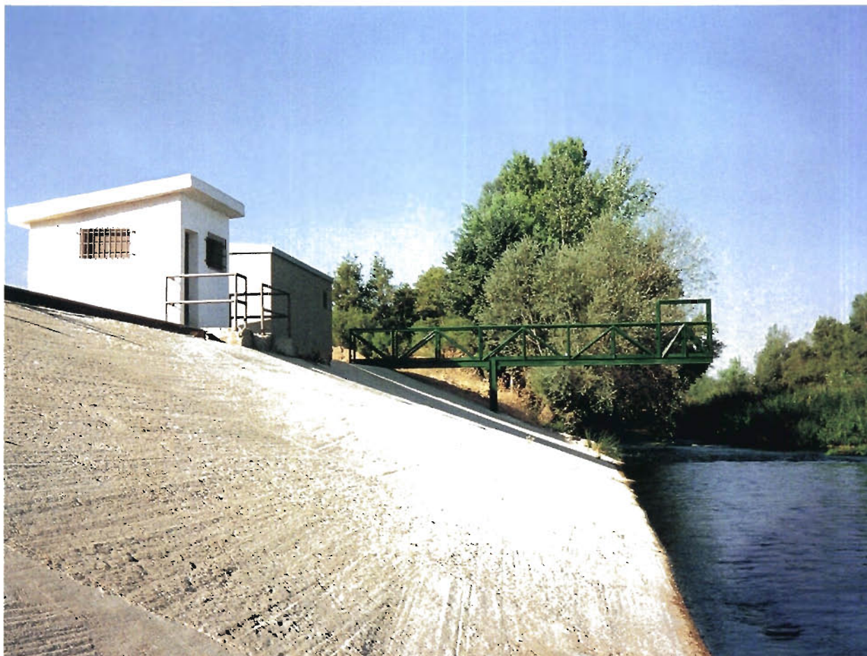
Estación automática de control de calidad del agua de la red RECCA, situada en Santos de la Humosa, a orillas del río Henares
