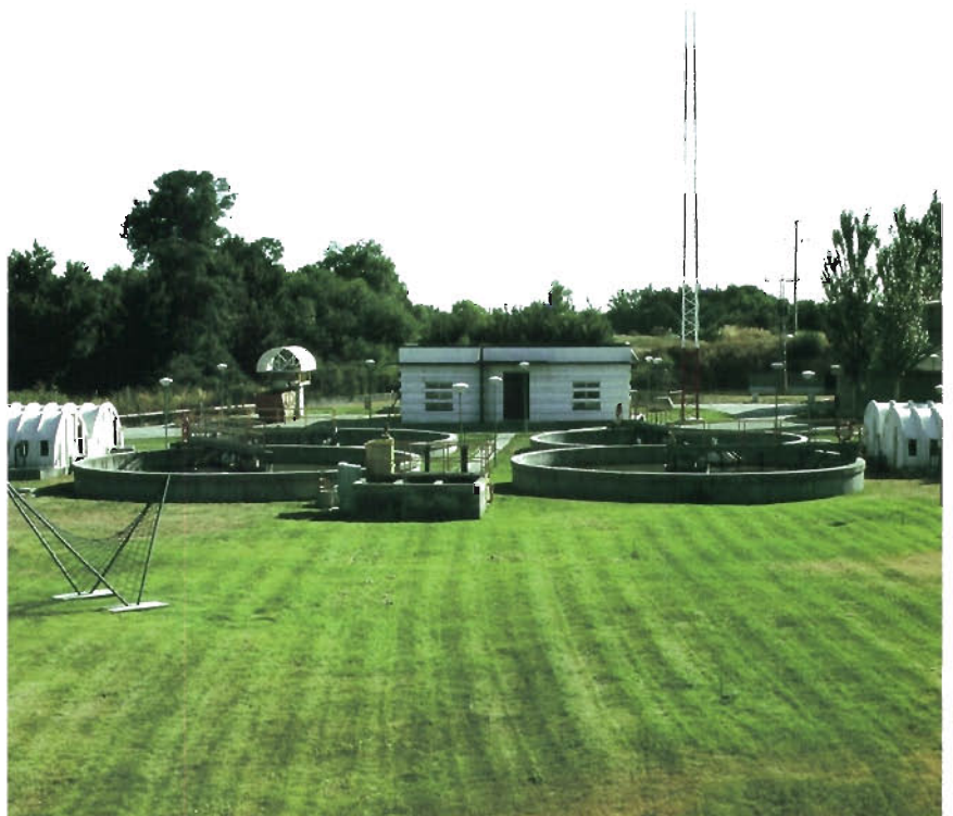
Depuradora de Boadilla del Monte
