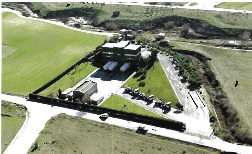
Estación de transferencia de San Sebastián de los Reyes
