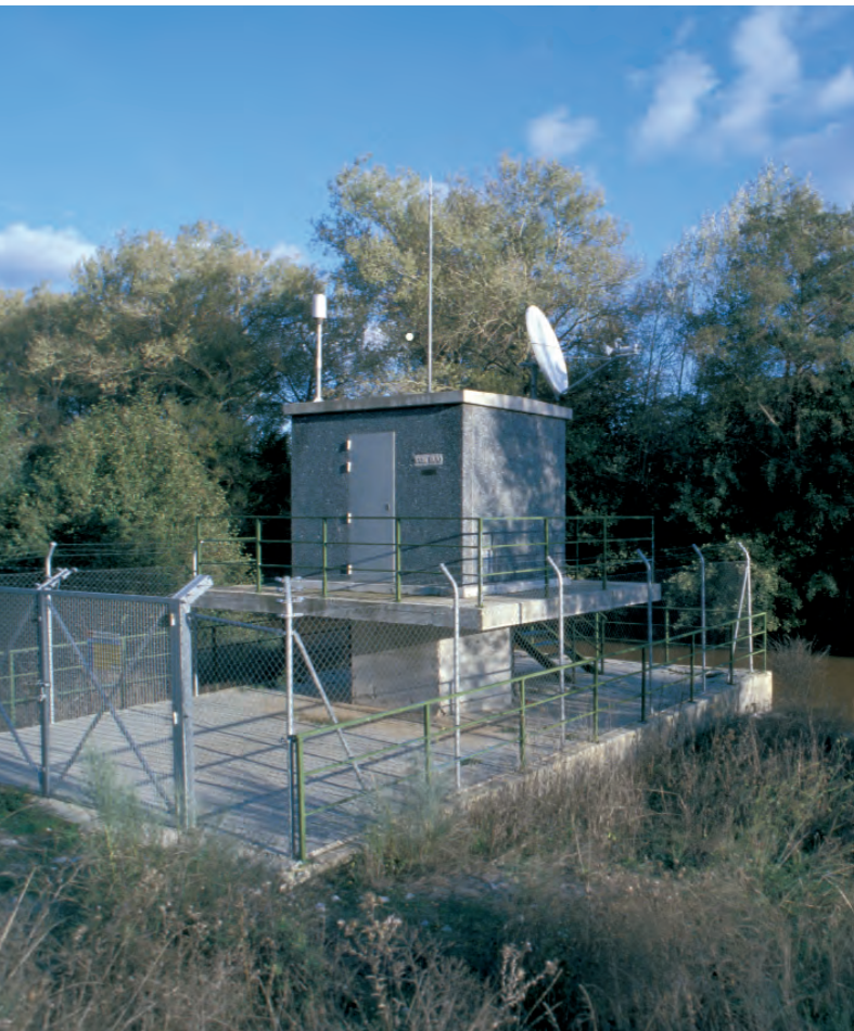
Punto de control del Sistema Automático de Información Hidrológica (SAIH). Confederación Hidrográfica del Tago.
