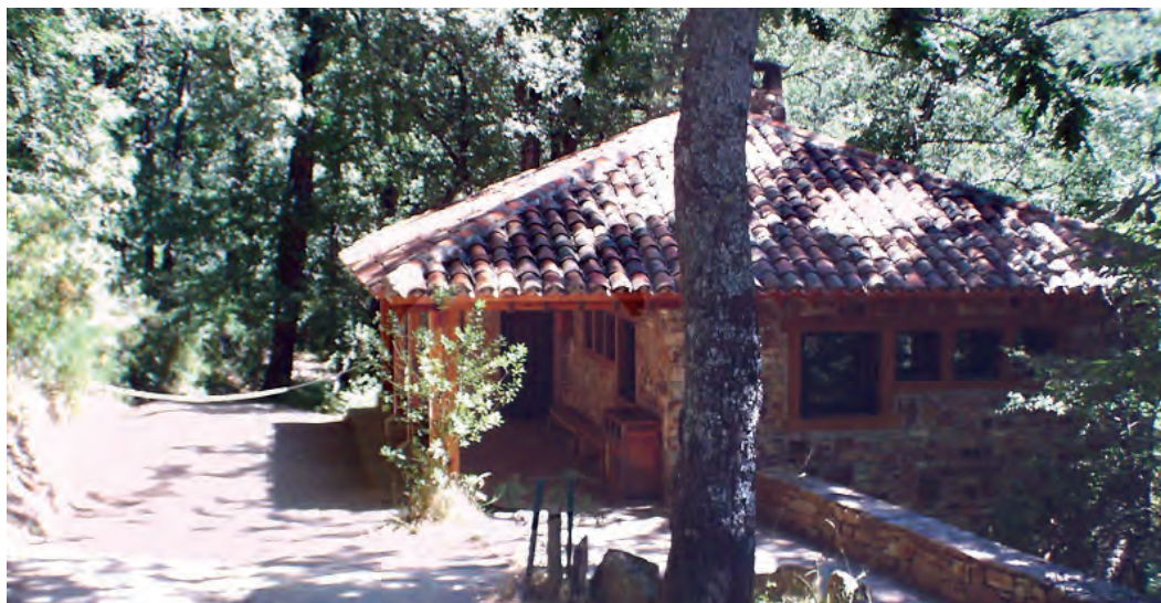
Infraestructuras. Centro de Educación Ambiental Hayedo Montejo. Casa del Hayedo
