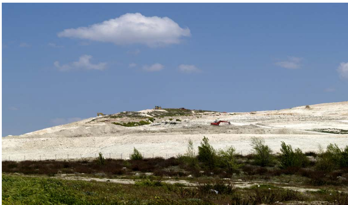
Actuaciones de recuperación de un antiguo vertedero.
