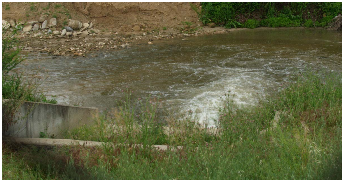
Vertido de aguas depuradas al río Manzanares.
