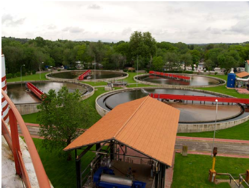
Las depuradoras generan lodos que tras su tratamiento son usados como abono
