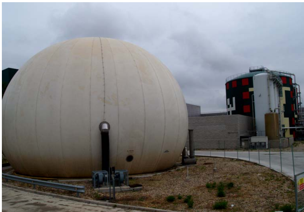
Gasómetro en la Planta de Biometanización de Pinto
