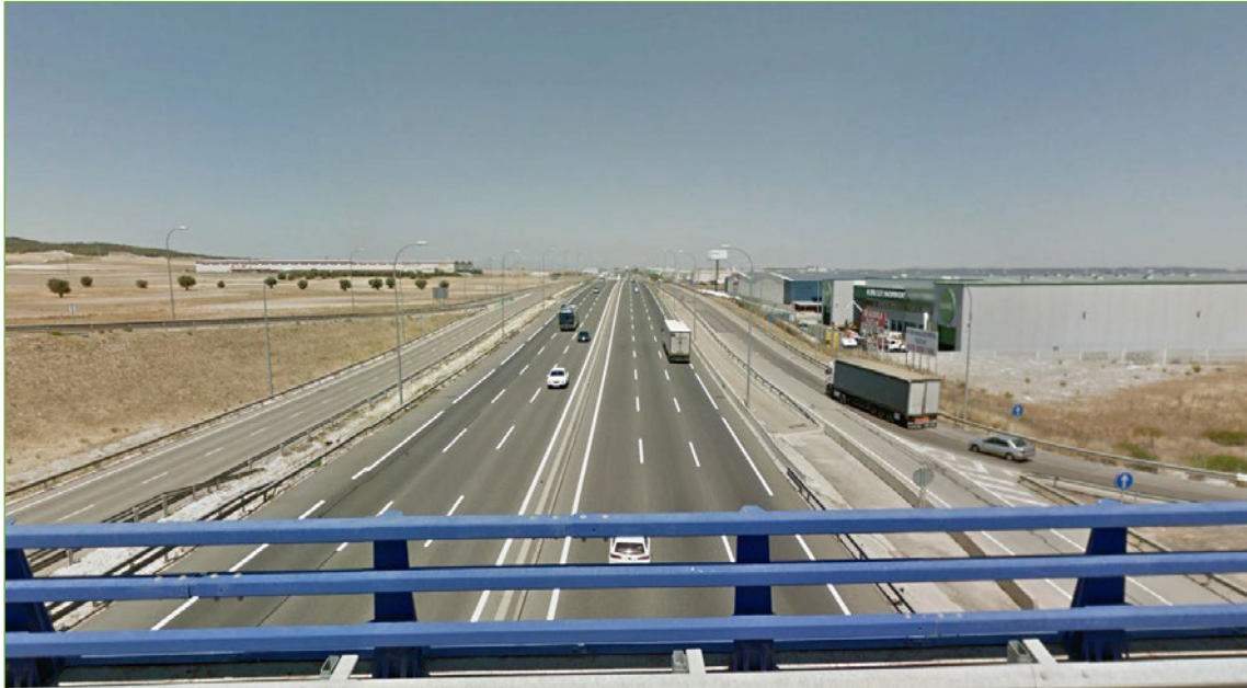
Figura 38. Tramo de la autovía A-4 en las proximidades del municipio de Valdemoro. Fuente: Google Earth.
