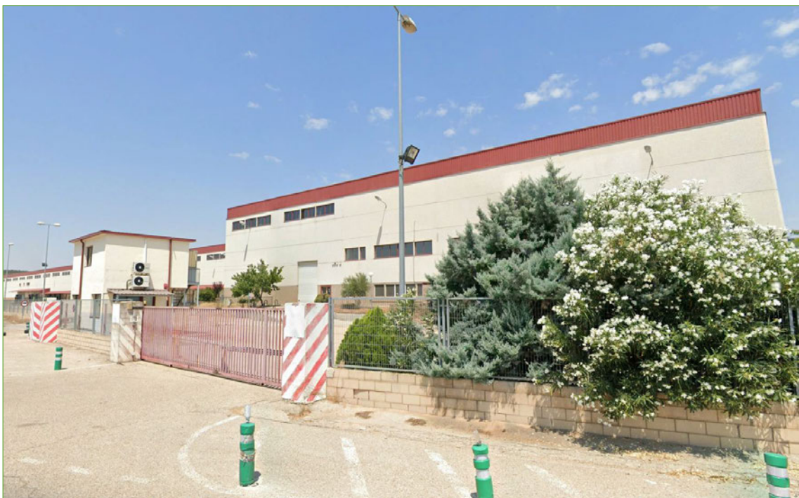
Figura 33. Servicio de logística "Transcentro Marín", localizado al sur de la planta fotovoltaica. Fuente: propia.
