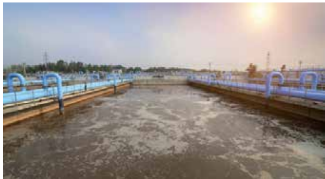
Aspecto de una estación de depuración de aguas residuales
