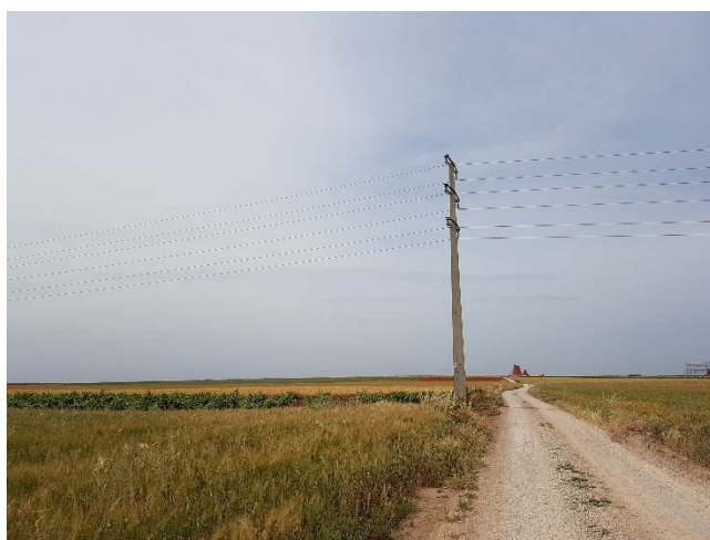
Fig 13 Imagen de línea aérea en cruzamiento.
