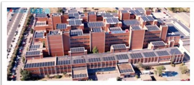
Instalación y puesta en funcionamiento en el ámbito de Gestión, dentro del Programa de Eficiencia Energética, de 3.197 paneles fotovoltaicos para el ahorro y consumo energéticos. Con la incorporación de estos paneles solares, el Hospital
