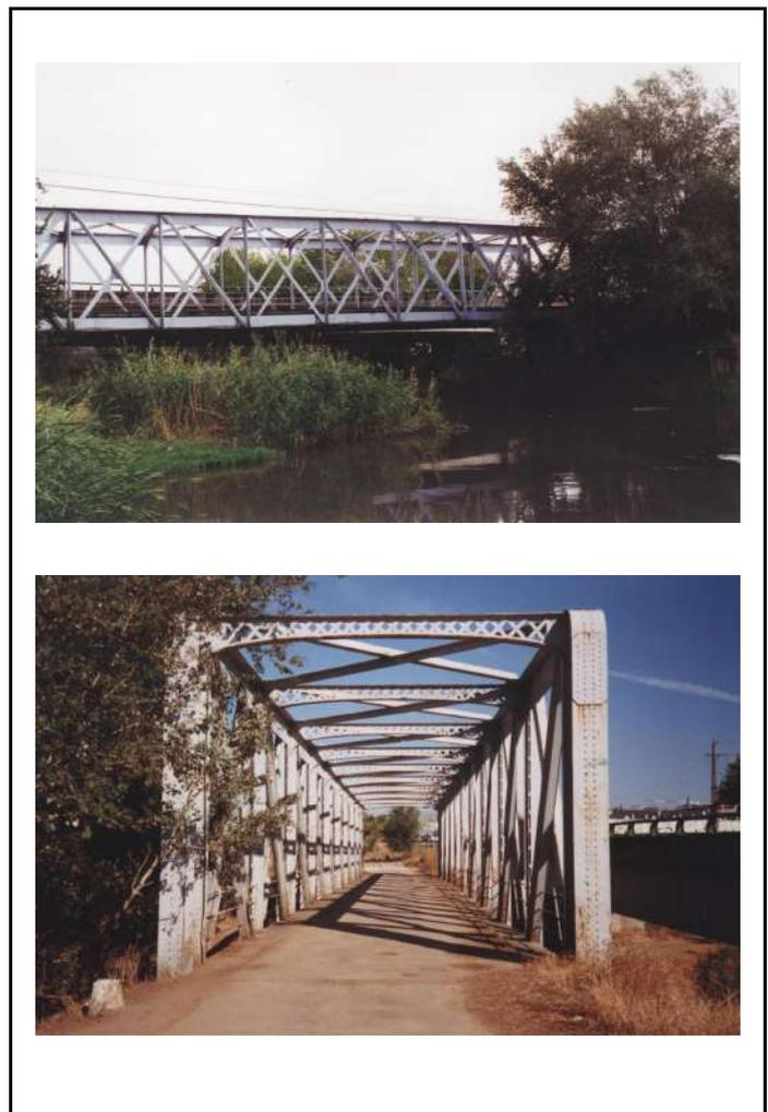
**OBSERVACIONES** Se encuentra en una situación de progresivo deterioro incrementada por estar en un tramo de carretera ya sin uso. Debería restaurarse el puente incluyendo en el proyecto la adecuación de su entorno y la creación de un área de recreo.
