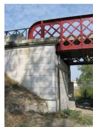
OBSERVACIONES: Los “quitamiedos” metálicos puestos como defensa en las embocaduras del puente resultan inconvenientes en el resultado final de la reciente restauración. Sería conveniente su eliminación o sustitución prolongando la barandilla colocada entre ellas y la viga que forma el pretil.
