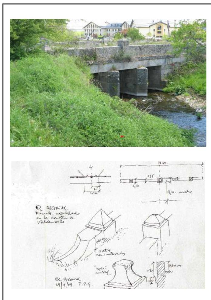
**OBSERVACIONES:** Su estado es lamentable. El pretil apenas se manifiesta al interior a causa del incremento del nivel de rodadura de la calzada. Tiene además piezas caídas o desplazadas de su lugar. Su abandono ha producido la invasión incontrolada de vegetación. El entorno, a pesar de estar en el borde del casco, se encuentra sucio y degradado. Es urgente la restauración y limpieza del conjunto.
