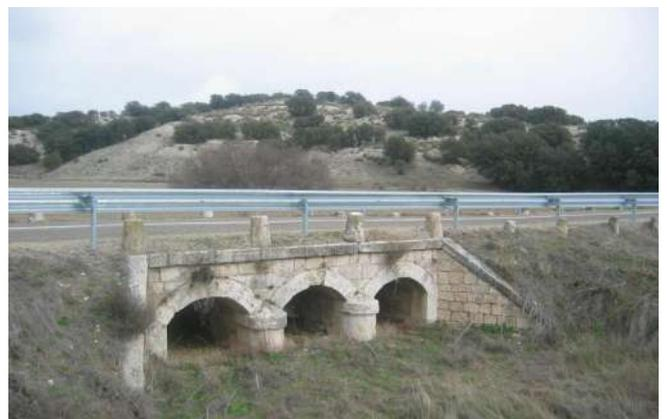
**OBSERVACIONES:** El estado general del conjunto es de notable descuido, con invasión de la vegetación, sobre elevación del nivel de rodadura y aterramientos sucesivos que han cubierto parte de las pilas y tajamares. Unos quitamiedos continuos de chapa ondulada pasan junto a los pretils y bordes y, en algún caso, su fijación se ha llevado a cabo con un desprecio absoluto a la obra de fábrica produciendo destrucción de sillares.
