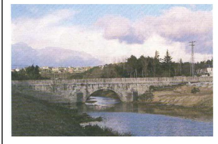
**OBSERVACIONES:** En 1985, como consecuencia de la ampliación de la carretera, se inició el desmontaje y transformación del puente, obras que se lograron paralizar mediante incoación de expediente para su declaración como BIC. Hubo entonces que reponer pretils y reconstruir la coronación de los tajamares y las gárgolas, lo cual, aunque correctamente realizado, no llegó a devolverle la perfección de su estado original.
