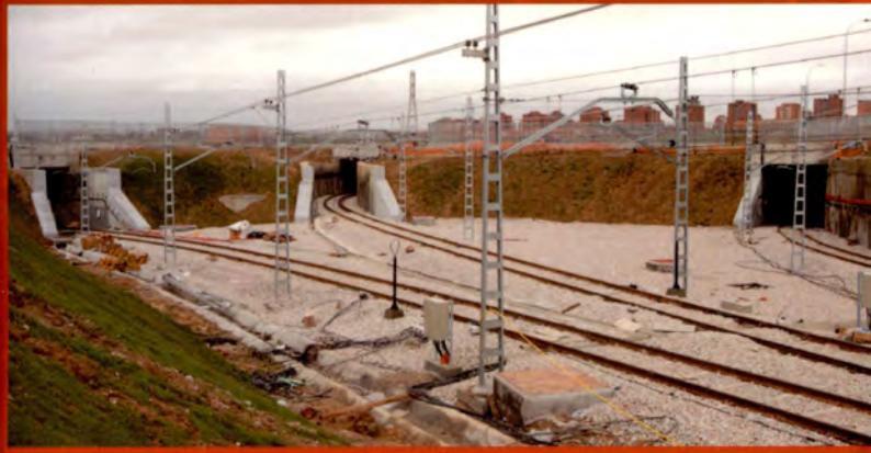
Para la conexión con el túnel de la vía general de Metrosur, se ha optado por la solución de realizar tres túneles de pantallas de pilotes, de longitud 350 m cada uno y cuya sección está constituida por dos alineaciones de pilotes de hormigón armado ejecutadas desde la superficie del terreno.
