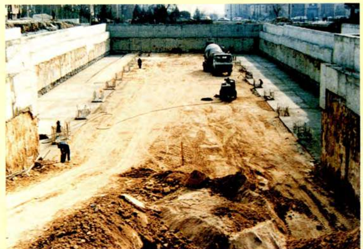
EXCAVACION BAJO CUBIERTA Y HORMIGONADO SOLERA Y ANDENES.
