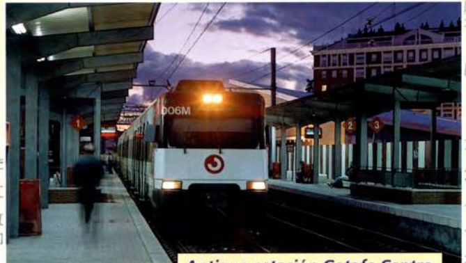
Antigua estación Getafe Centro
