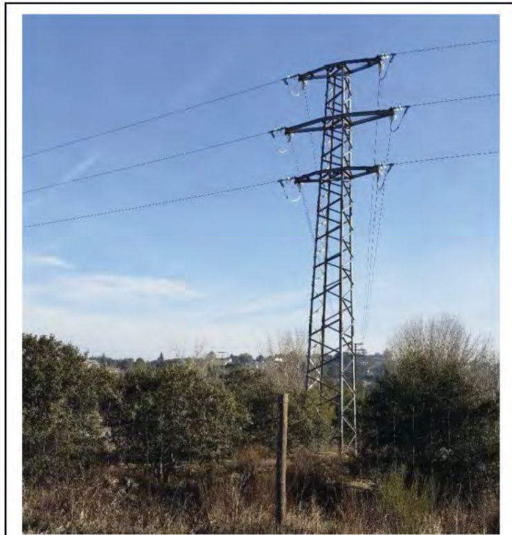
Fotografía 3. Inicio de la línea eléctrica
