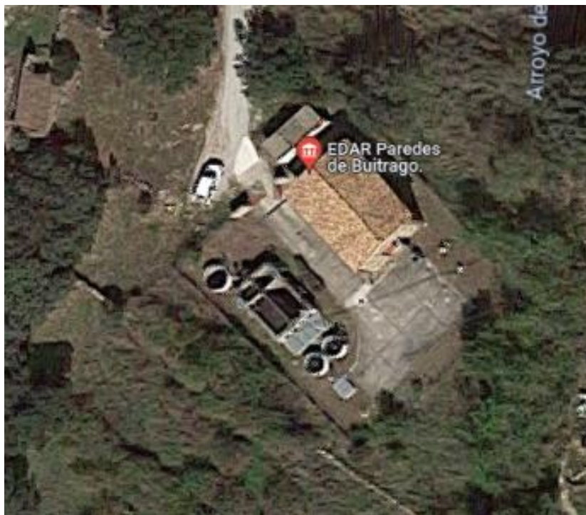
Figura 267. EDAR de Paredes de Buitrago. Fuente: Google Maps
