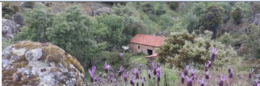
Vista panorámica hacia el molino y el arroyo. Fuente: sierranortemadrid.org
