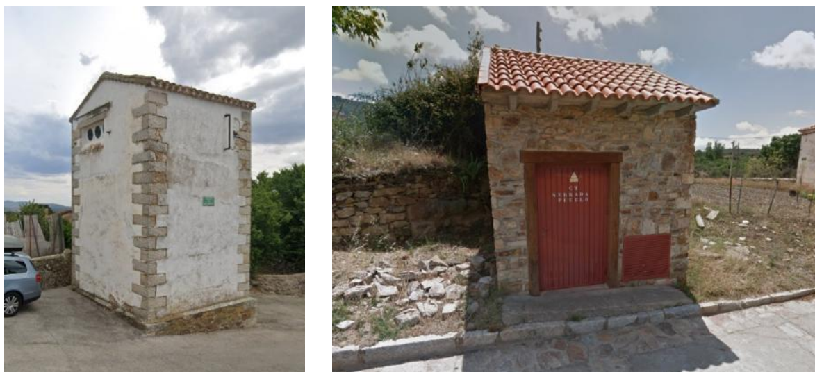
Figura 275. Centros de transformación eléctrica. Fuente: Google maps.
