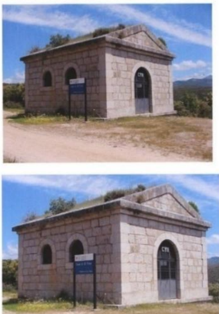
ALMENARA DE 'LA TEJERA' (Canal de El Villar). IPICAM 2003. MANJIRON (Puentes Viejas) 902/21
