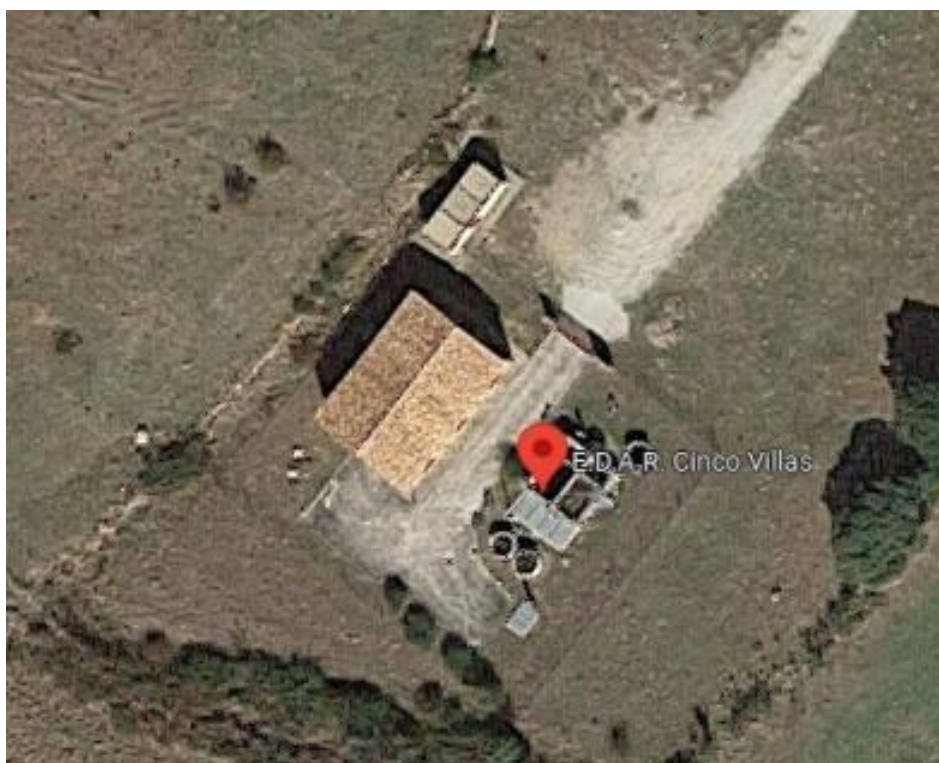
Figura 263. EDAR de Cinco Villas. Fuente: Google Maps.
