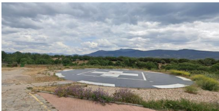
Figura 246. Helipuerto de Mangirón. Fuente: Google maps.
