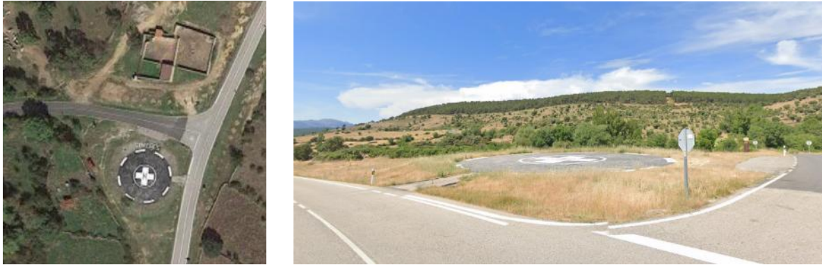
Figura 247. Helipuerto de Paredes de Buitrago. Fuente: Google maps.
