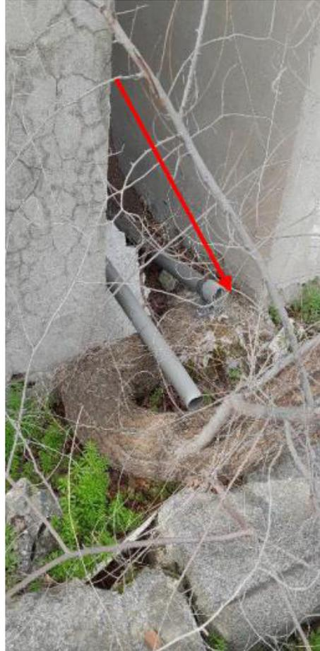
En las imágenes anteriores, se observa cómo este pie nace debajo de la cimentación del edificio, provocando así inestabilidad e inclinación del mismo.
