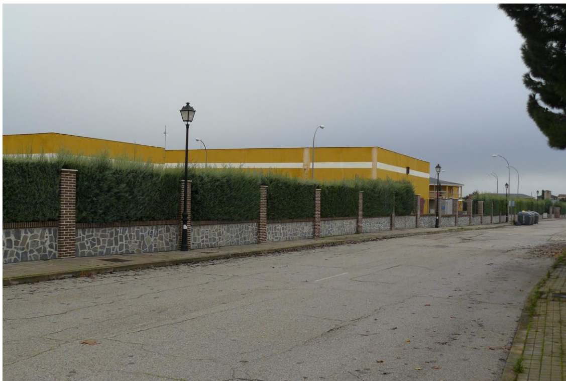
Figura 3.2.3.1.- Depósito de Griñón. (Fuente: Elaboración propia)
