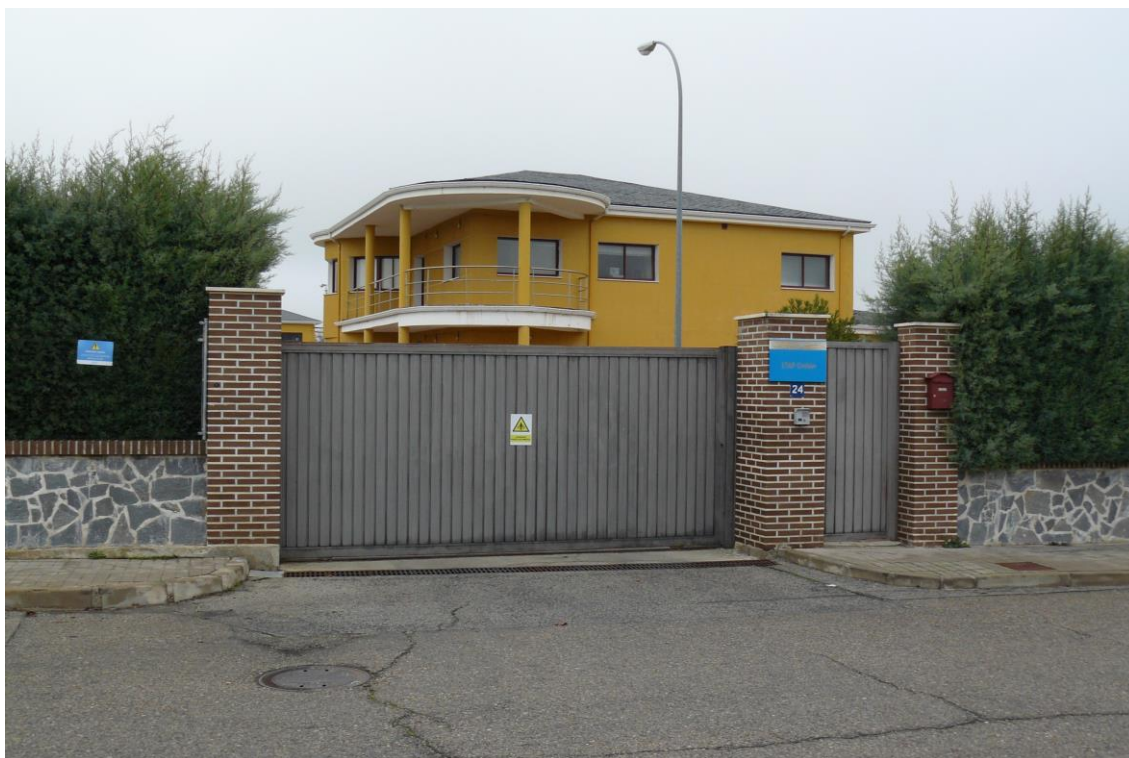
Figura 3.2.3.2.- E.T.A.P de Griñón (Fuente: Elaboración propia)
