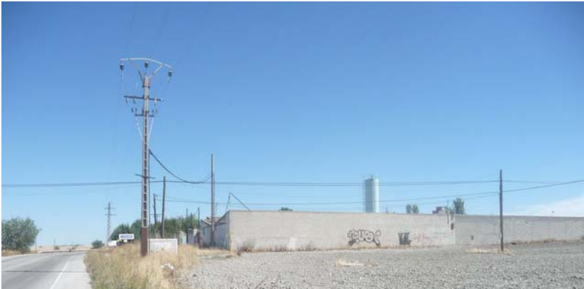
Línea eléctrica de media tensión paralela al a la Camino de Pinto a la Marañoso
